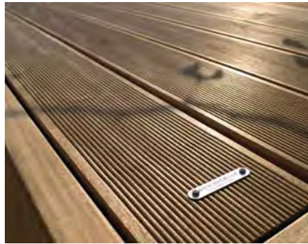
superior: iluminación perimetral centro e inferior: material "deck"
