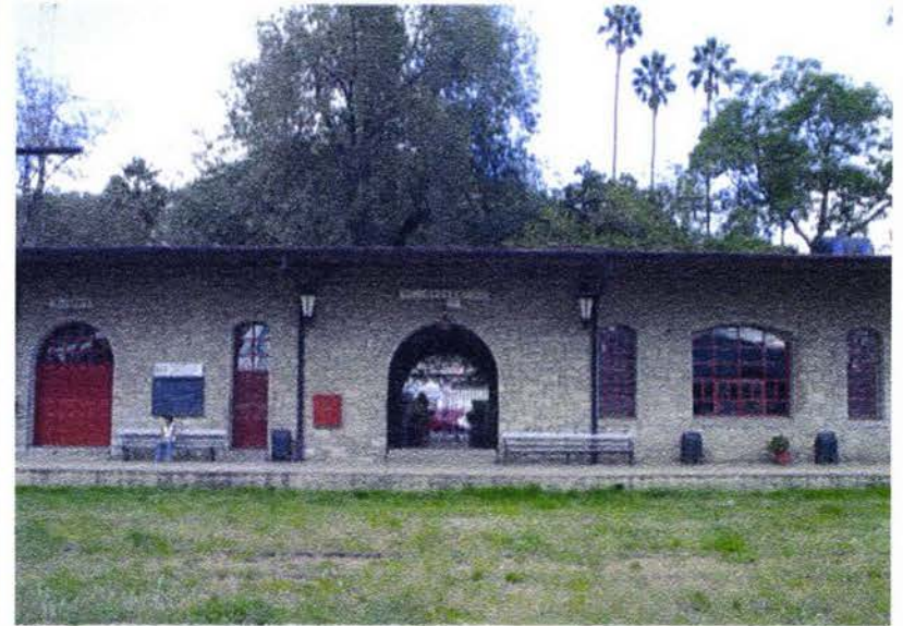
VISTA DE LA ESTACIÓN Y ANDÉN DESDE EL PATIO DE MANIOBRAS
