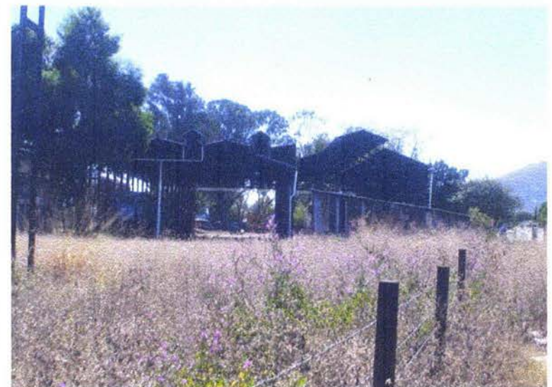
FACHADA LATERAL DEL TALLER
