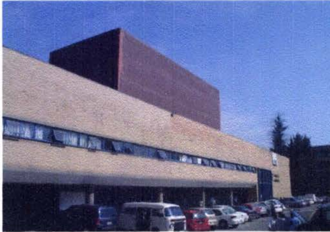
VISTA EXTERIOR, EL CUBO DE TELONES, GENERA UN ELEMENTO ESCULTORICO
