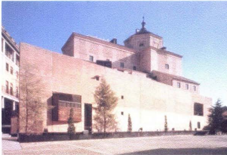
ELEMENTO CONTEMPORÁNEO SOBREPUESTO A UN EDIFICIO ANTIGUO
