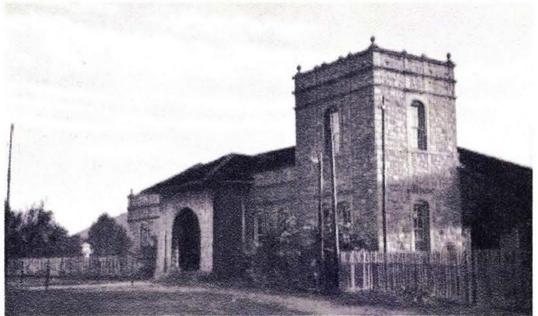
ESTACIÓN DE TRENES DE OAXACA, VISTA DEL FRENTE ANTES DE LA PÉRDIDA DEL TORREÓN, POR SISMO.
