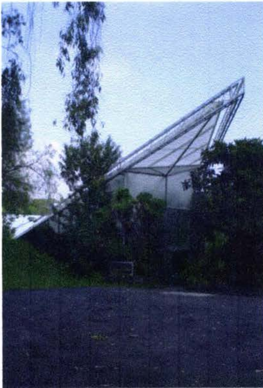
VISTA EXTERIOR, A BASE DE ELEMENTOS TRANSLUCIDOS PARA SU CORRECTO FUNCIONAMIENTO
