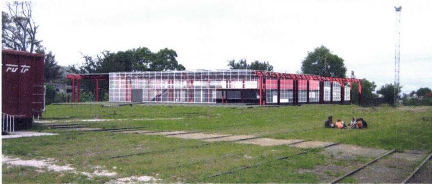
VISTA DEL EDIFICIO EN EL SITIO
