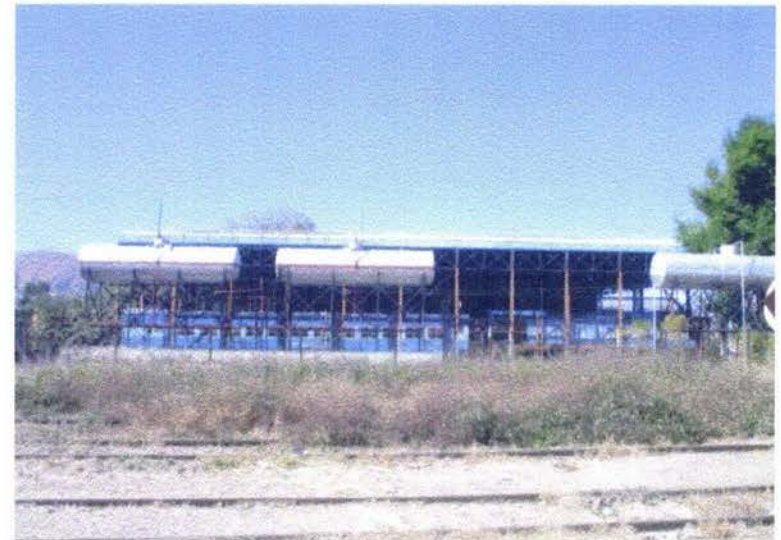
FACHADA DESDE EL PATIO DE MANIOBRAS, DEL TALLER
