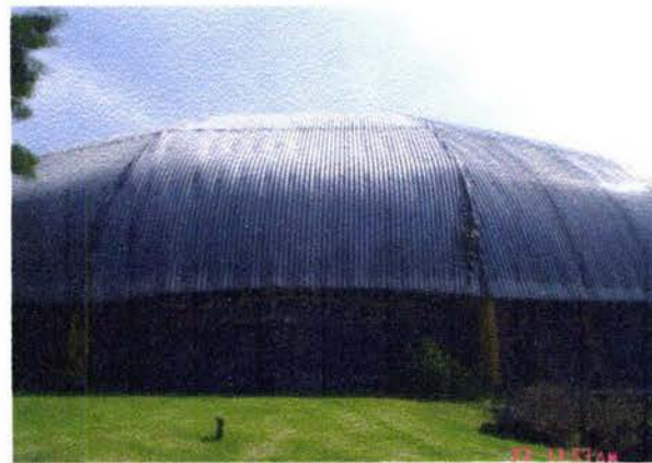
VISTA EXTERIOR, CUBIERTA TRANSLUCIDA, QUE GENERA CONDICIONES PROPICIAS PARA ESTA ACTIVIDAD.
