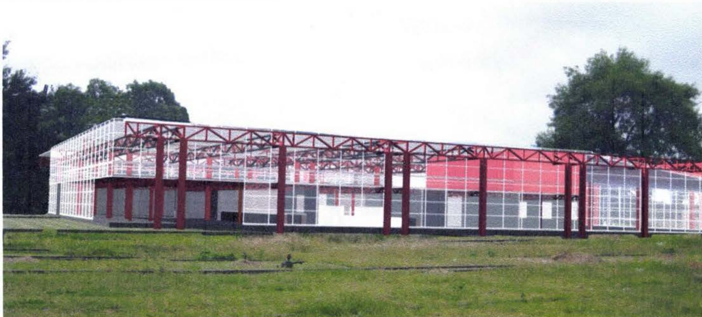
VISTA DEL EDIFICIO EN EL SITIO
