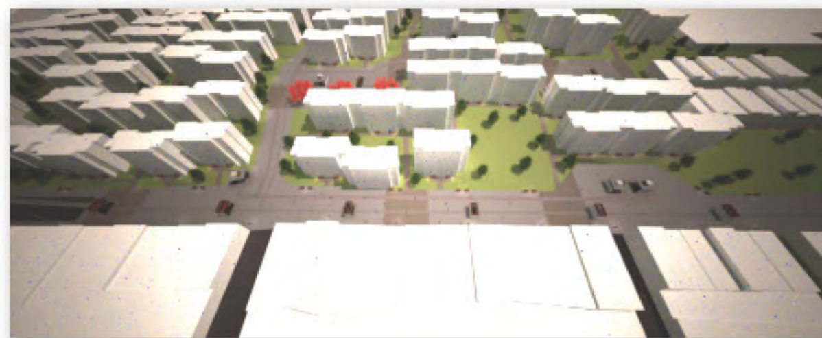
Panorámica del proyecto lado oeste.
