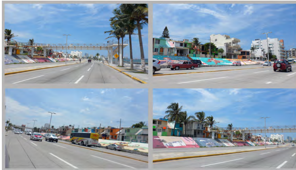
FIGURA 2. Vistas de la zona afectada.
