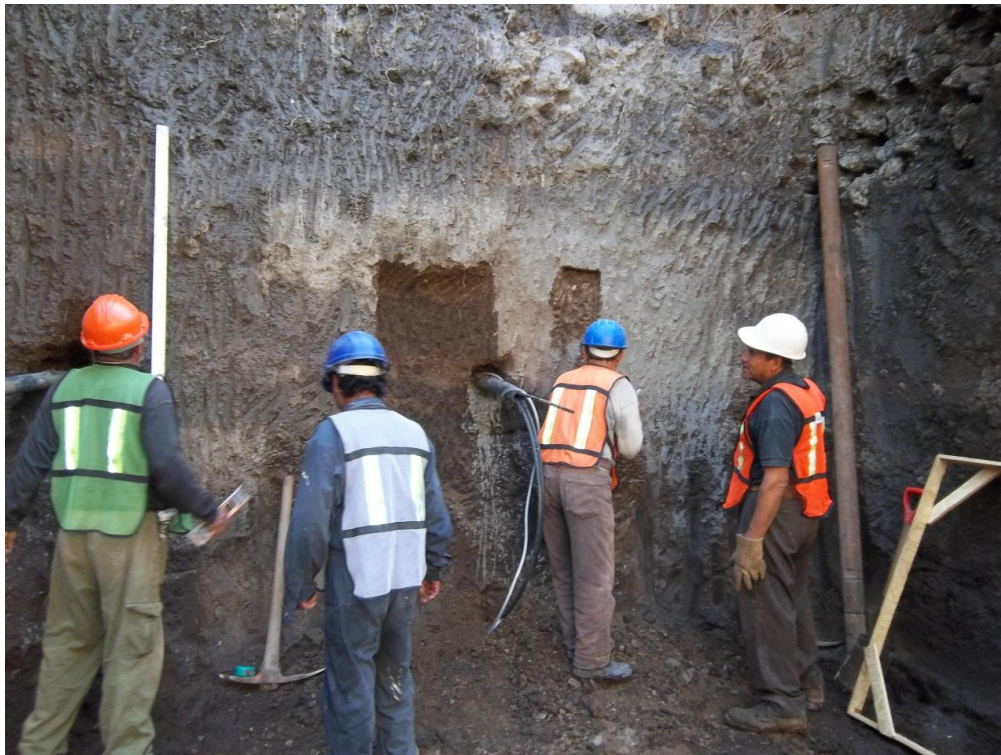
Figura 3.2.1 Habilitado de ancla
