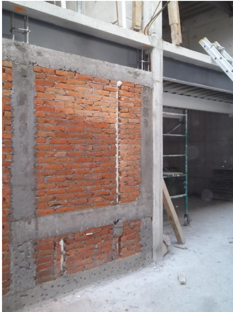
Figura 3.3.6 Muros de tabique
