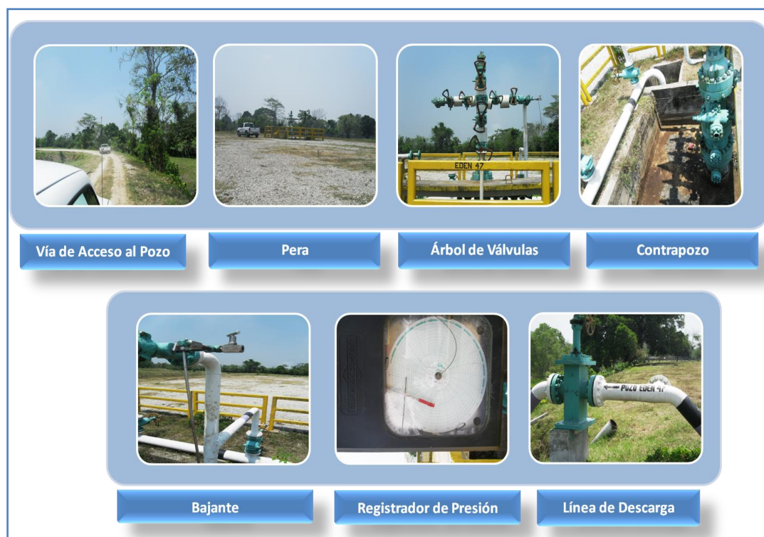
Figura 3.6.- Fotografías del Estado Actual del Pozo
