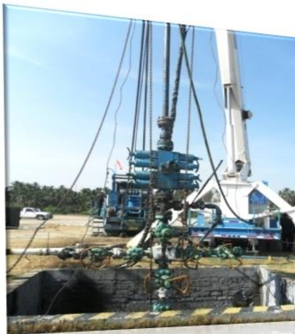
Figura 3.96.- Ejecución de la intervención del pozo (1 ra Etapa)
