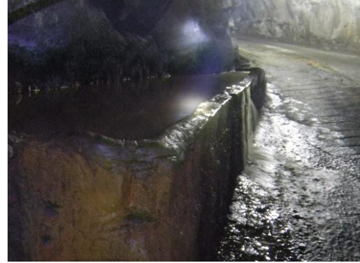
Figura 3-6 Pileta de captación del DAM
