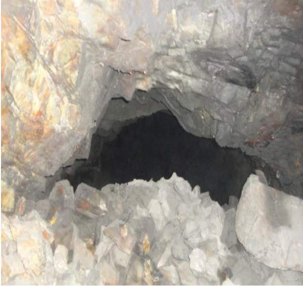
Figura 5-1 Rebaje viejo, carga acumulada 4to escurrimiento.
