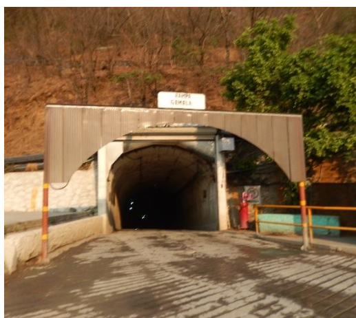
Figura 4-1 Acceso "Rampa Gemela"
