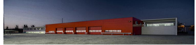
Vista de la Fachada (Parte Atrás)
