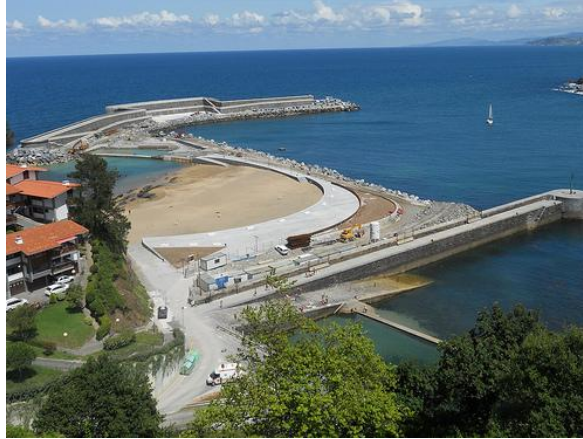
Figura 3.11 El puerto de la localidad vasca de Mutriku con la central instalada en la parte exterior del dique [Ortubia, 2008]
