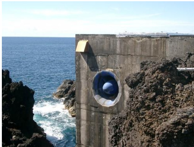
Figura 3.12 Vista aérea del sistema OWC en Pico , Portugal [Brito, 2010]
