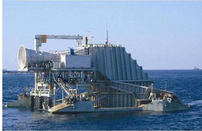
Figura 3.13 Sistema OWC en las costas de Australia [Falcão AFO, 2010]
