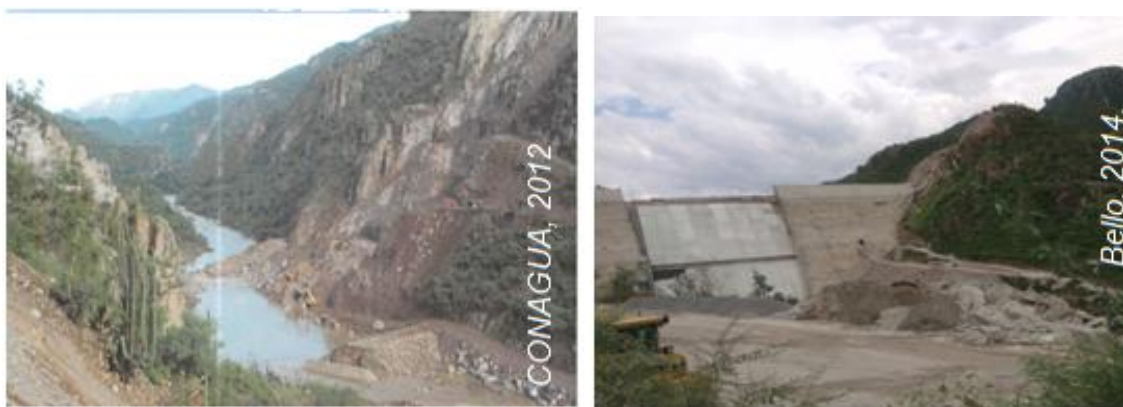
Figura 2.6. Construcción de la cortina de la presa El Realito.
