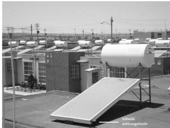
Figura 16. Calentador solar termosifón en viviendas verdes.
