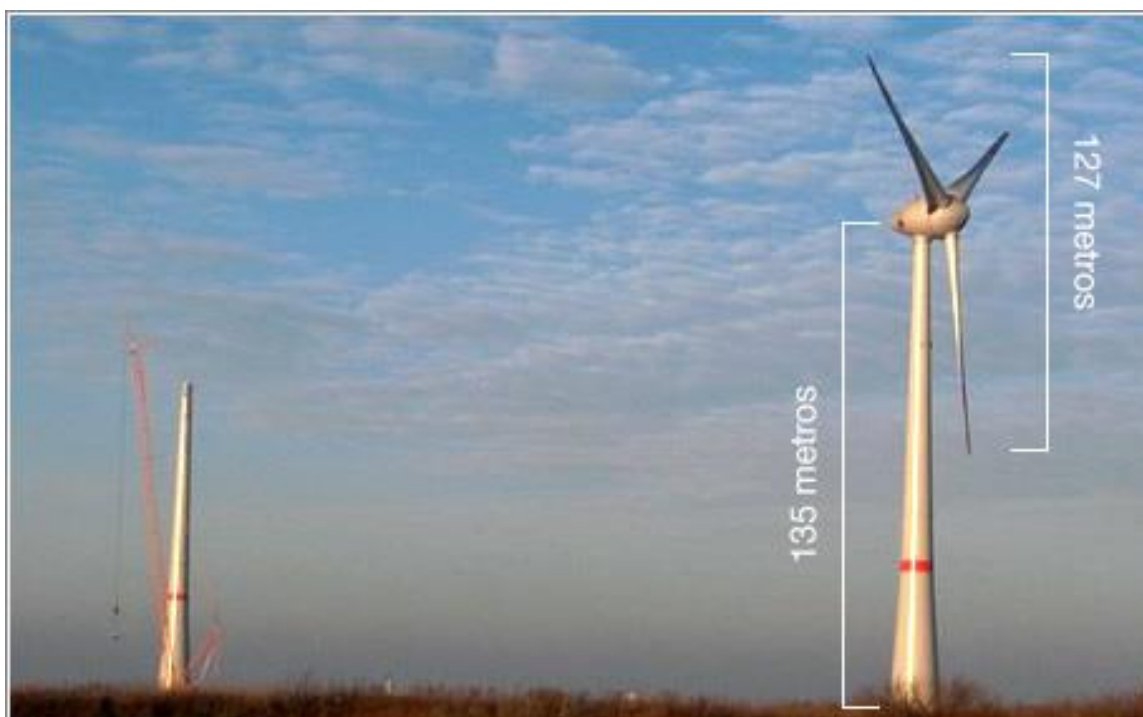
Figura 2.4 E-126 el aerogenerador más grande del mundo. Instalada en Emden, Alemania, donde se calcula que producirá hasta 20 millones de KWh al año.
