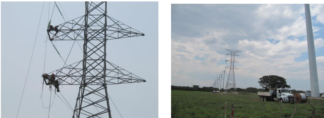
Figura 4.6 Colocación de cable y afectación de paisaje
