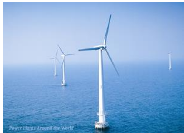
Figura 3.1 principal parque eólico en Vindeby en Dinamarca
