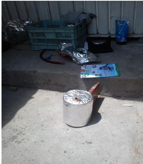
IMG. 12-AISLAMIENTO DEL TANQUE
