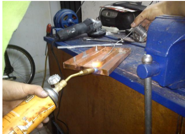
IMG. 5- SOLDADURA DE LAS ALETAS
