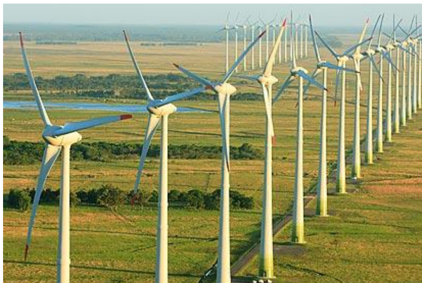
FIG. 1- SERIE DE AEROGENERADORES EN UN PARQUE EOLICO,
