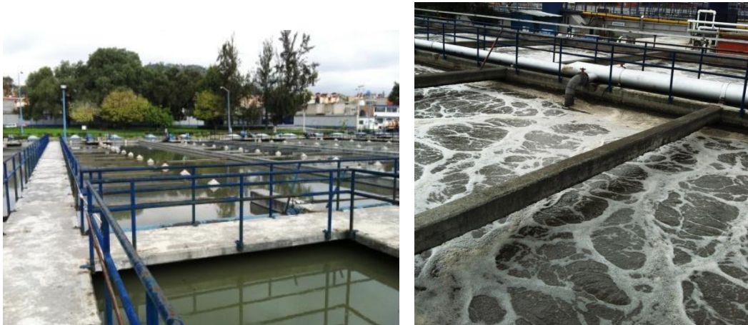
Figura 4.1. Sedimentador primario (izquierda) y reactor biológico (derecha) de la planta de tratamiento “Cerro de la Estrella”
