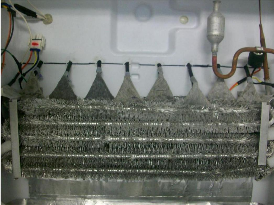
**Fig. 15 Vista frontal del evaporador “frío”, es decir, con el sistema de refrigeración funcionando. El evaporador se encuentra limpio y libre de escarcha. El sistema de aspersión de agua se encuentra apagado.**
