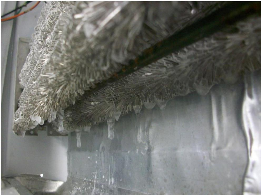
**Fig. 34** Imagen de escurrimientos de agua congelados en la parte baja del evaporador.
