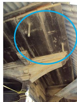
**Figura 66.** Clavijas de sujeción del arrastre al tablón. Caso: TP-3. Fuente: Archivo personal. Octubre, 2010.
