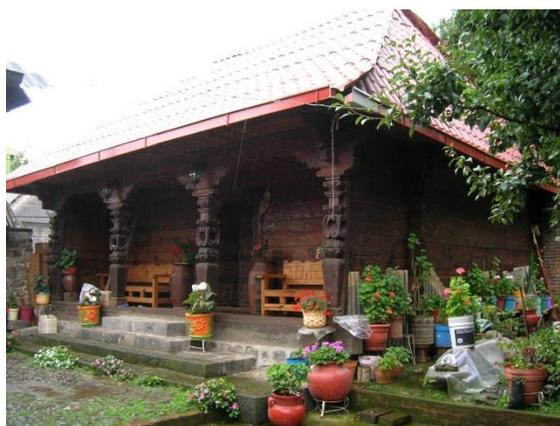
**Figura 39.** Pórtico de *troje* con cuatro columnas que rematan en su parte superior con zapatas.
