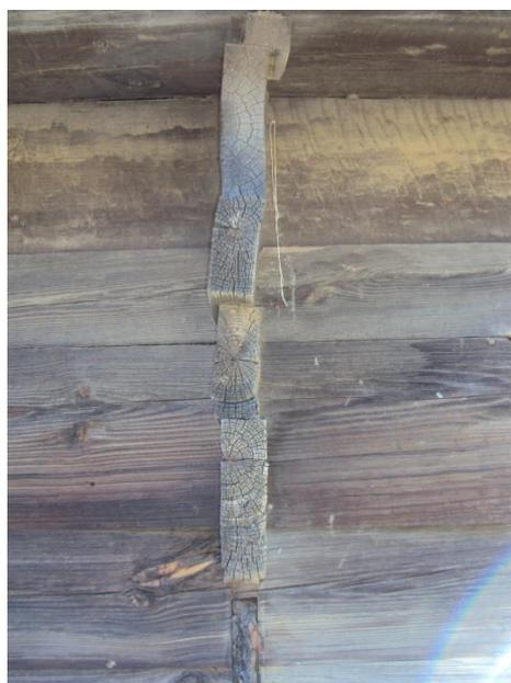
**Figura 56.** Los anillos de crecimiento del árbol son evidentes en las secciones de los tablones de los muros de una *troje*.
