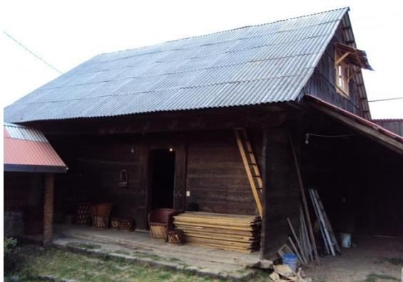
**Figura 38.** Pórtico de *troje* sin columnas. Caso: TP-5.
