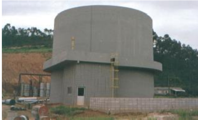
Figura 1.3 Biodigestor de régimen estacionario. (Torre Guillén D., 2009)
