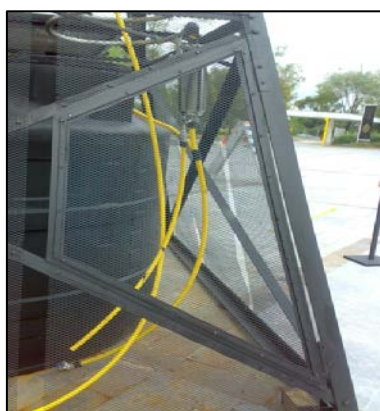
Figura 4.11 Tubería de interconexión entre los sistemas
