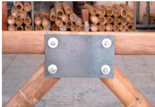
FOTOGRAFIA N° 18. Detalle unión tipo pletina rectan ular.
