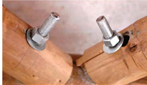
**FOTOGRAFIA N° 53.** Rajadura en las paredes de elemento diagonal a tensión.
