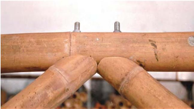
**FOTOGRAFIA N° 22.** Detalle unión tipo anclaje axial.
