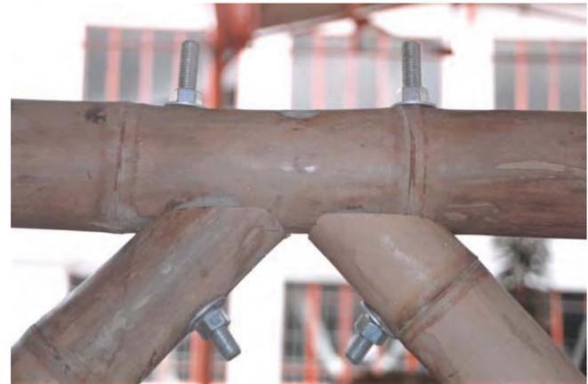
FOTOGRAFIA N° 20. Detalle unión tipo ancla e.
