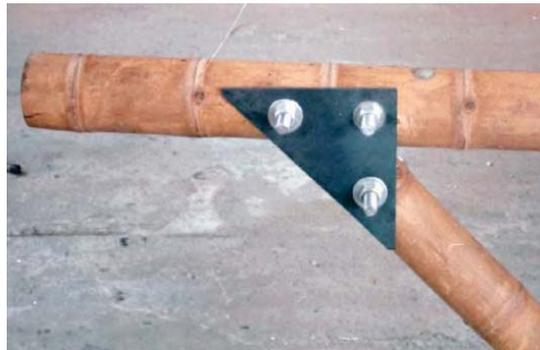
FOTOGRAFIA N° 17. Detalle unión tipo pletina trian ular.
