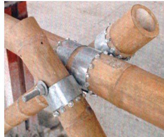
**FOTOGRAFIA N° 15.** Detalle unión tipo abrazadera.
