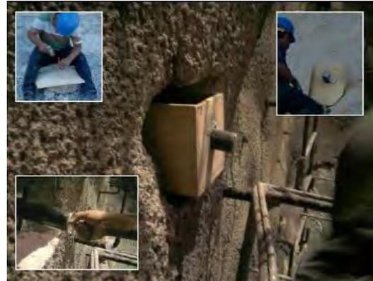
Fotografía 4.4. Colocación de cimbra, arriba izquierda corte de cimbra en sitio, abajo izquierda medición de distancias regulares, derecha cimbra diagonal (EMG-GEIC, Mayo 2010).
