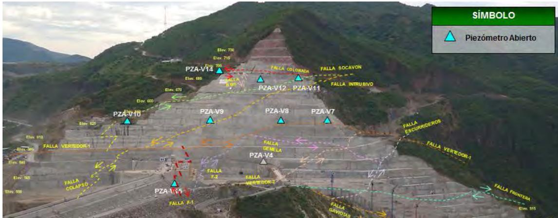
Figura 5.14. Ubicación de piezómetros abiertos instalados en la obra de excedencias (GEIC, Octubre 2012).
