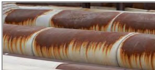
Figura 1. La corrosión en ductos.
