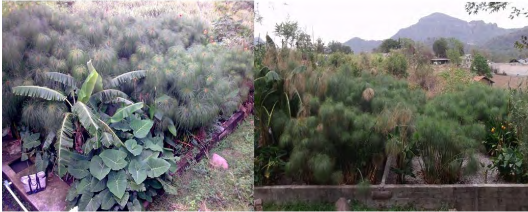
Figura 4. Fotografías del humedal artificial de flujo subsuperficial, vista frontal y vista lateral.
