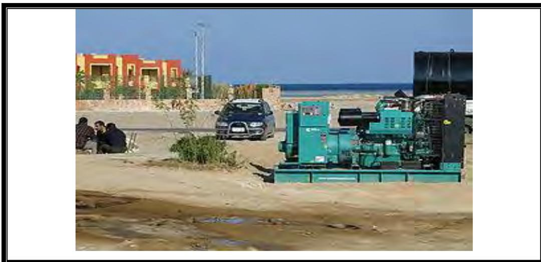
Fig. 3.11 grupo electrógeno de 500 KVA, instalado en un complejo turístico en Egipto.
