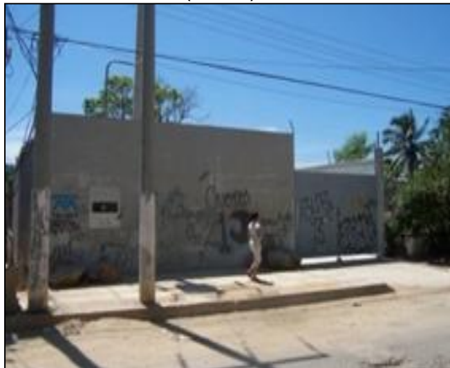
POSTES DE TELÉFONOS (TELMEX)
