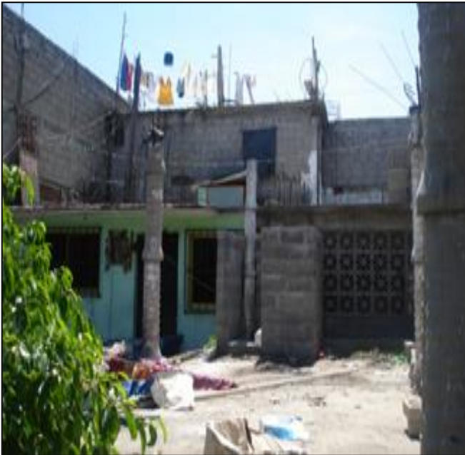
CASA EDIFICADA SIN SUPERVISIÓN ADECUADA FIGURA 4.25
