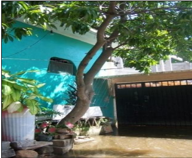
INUNDACIÓN POR LAS FUERTES LLUVIAS FIGURA 4.19
