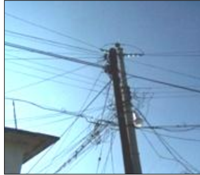
EXCESIVO CABLEADO EN POSTES
