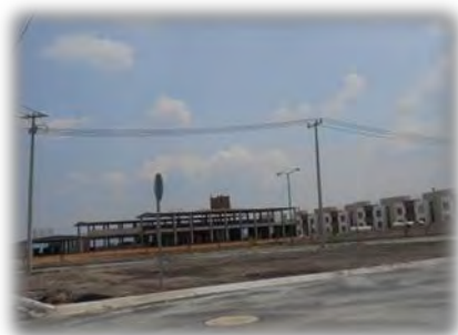
Avance de escuela primaria de 18 aulas
