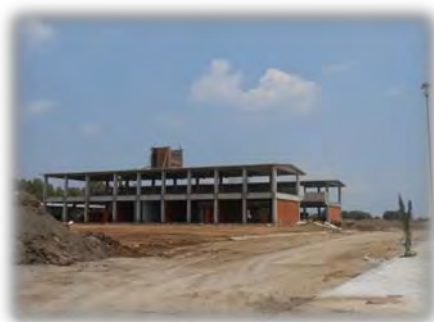
Equipamiento educativo en proceso de construcción.
