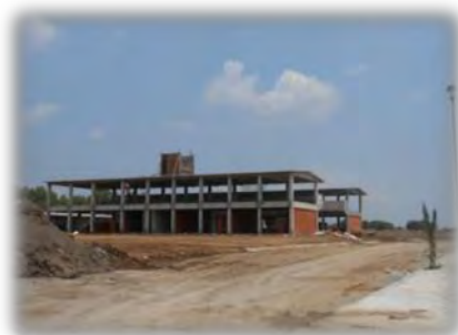
Avance de escuela primaria de 16 aulas
