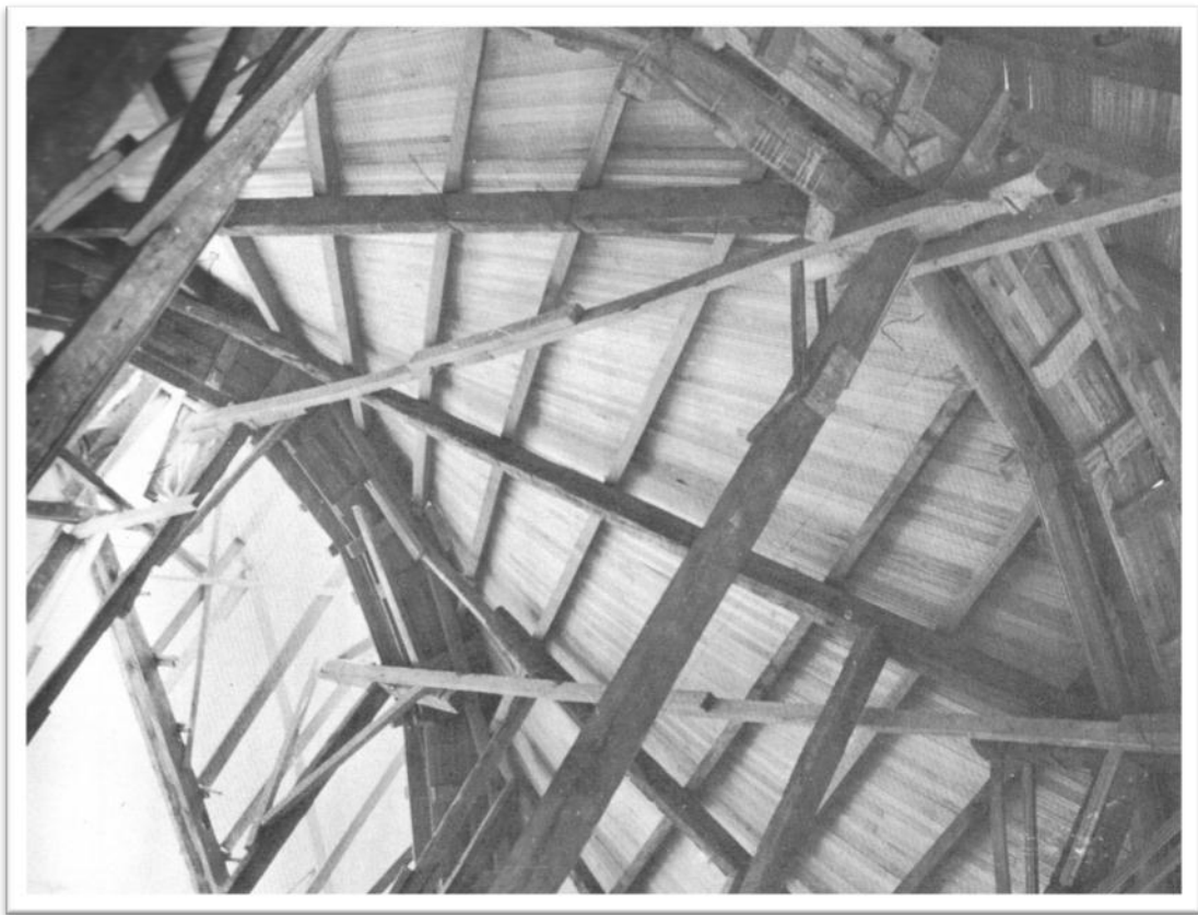
Fig. 14. Cimbra vista desde el interior del Pabellón de Rayos C3smicos.
