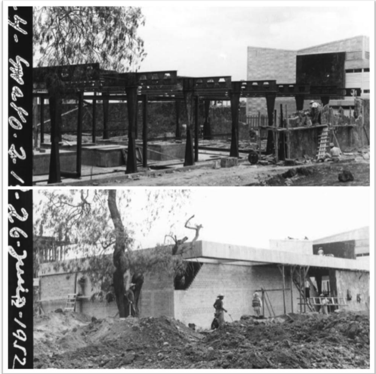
Fig. 10. Construcción del Pabellón de Gravitación.
