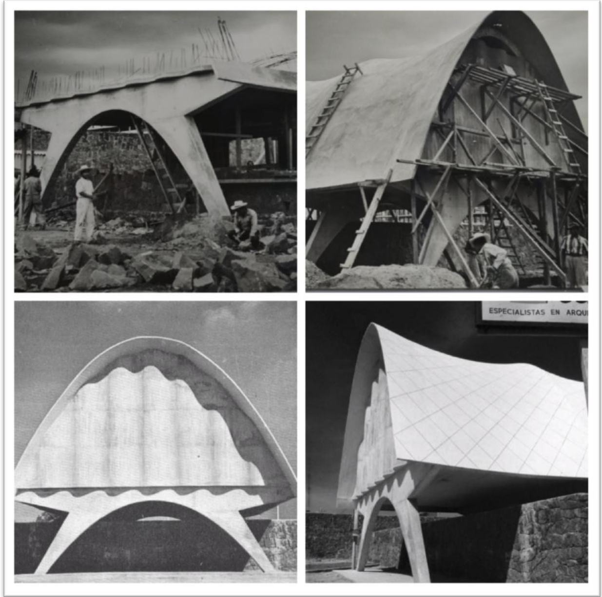
Fig. 4. Construcción del Pabellón de Rayos C3smicos.
