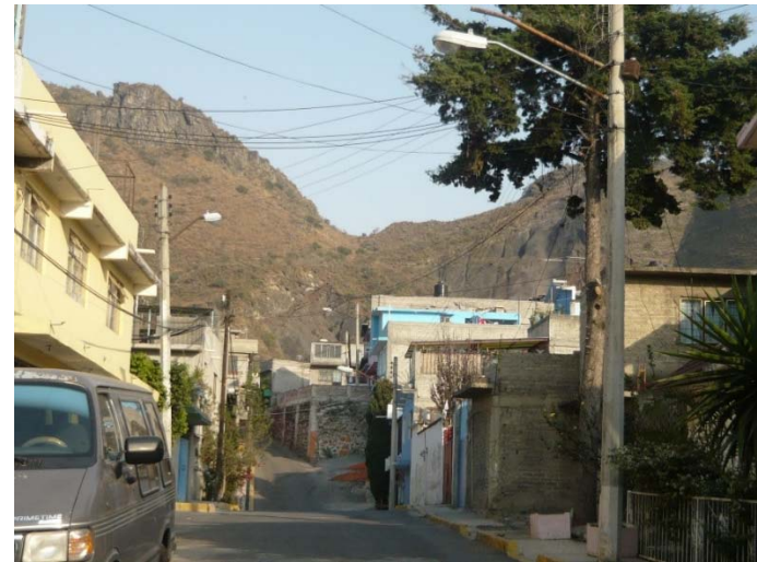
El cambio de los asentamientos de la Sierra de Santa Catarina. Arriba. Imagen de los inicios de los asentamientos. 1990. Abajo, imagen actual. Fuente: Galería propia
