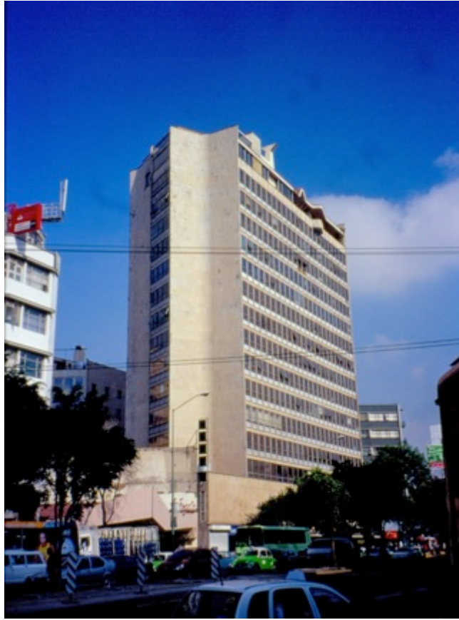
Figura no. 4 Edificio Aristos, vista sur desde la Av. Insurgentes y la calle Tlaxcala
