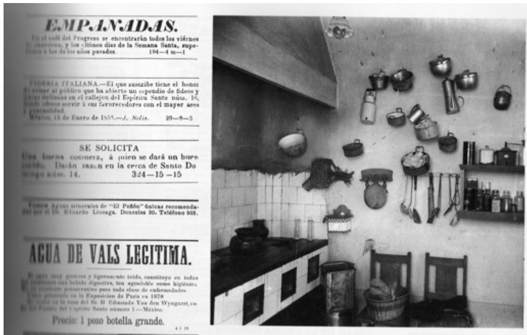
Imagen no. 6. Cocina con hornillas de combustión a leña, las ollas y cazuelas en la pared.
