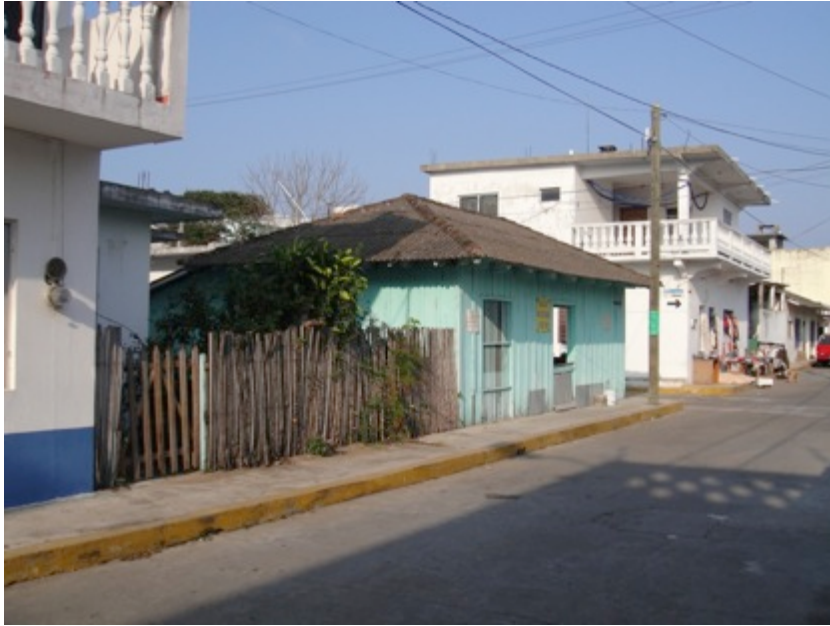
Imagen no. 63 Casa vernácula de madera con alero perimetral y techo inclinado, Tecolotla, Ver.
