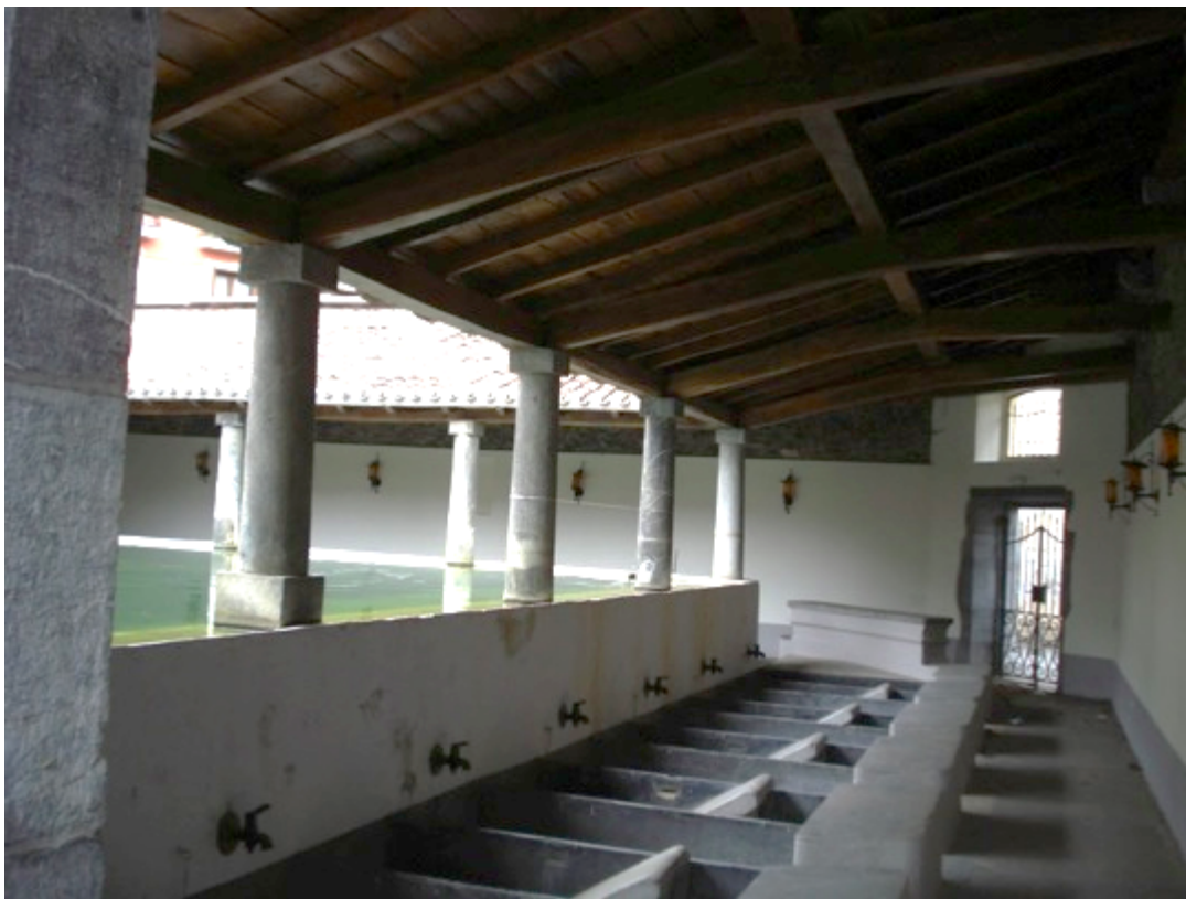
Imagen no. 60 Cubierta en lavaderos públicos en Azpeitia, España
