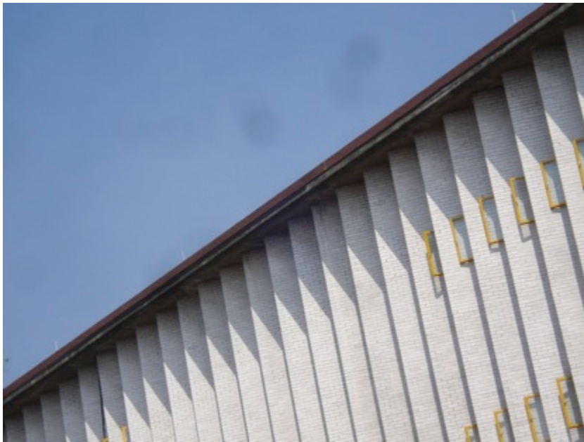
Imagen no. 64 Edificio de la Facultad de Ingeniería con partesoles integrados en la fachada poniente, Ciudad Universitaria, México D.F. Autores: Francisco J. Serrano, Fernando Pineda, Luis Mc Gregor
