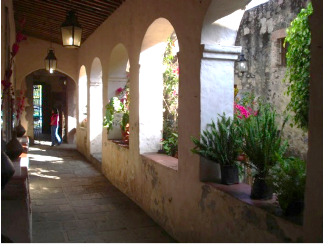
Imagen no. 72 Corredor al sur, que protege la pared del asoleamiento, Morelos.
