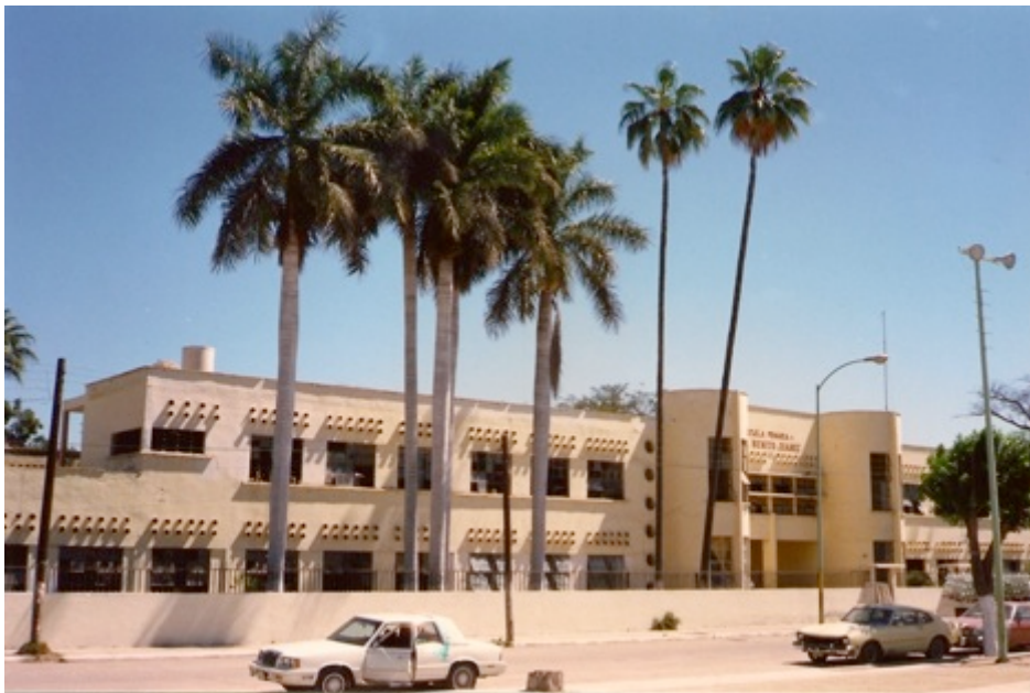
Imagen no. 1 Escuela Primaria Urbana “Benito Juárez”, Novolato, Sinaloa, 1950, foto 2008
