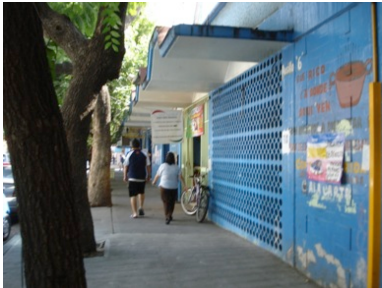
Imágenes no. 66 y no. 67 Casa con celosía para ventilar y protección; mercado con celosía de piso a techo y alero de protección
