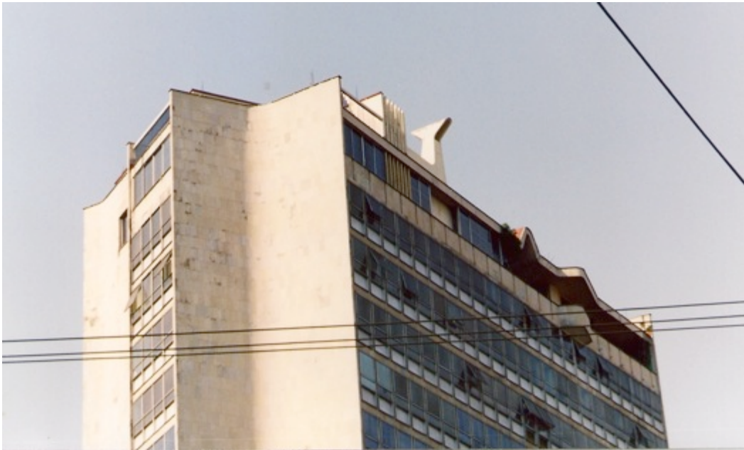
Imagen no. 5 Cartelas laterales de la estructura y remate del volumen
