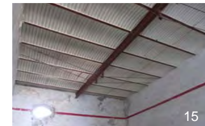
Imágenes 15-18.- El empleo de nuevos materiales en las construcciones de finales del siglo XIX como el acero en vigas y columnas, entresijos de bóvedas de ladrillo y lámina acanalada conocida como “Sistema Roebling”, sustituyó a los techos tradicionales de vigas de madera y terrados, (techos franciscanos). Fotos: Detalles constructivos del Molino San José, Jojutla, Morelos, Octubre 2011. IPV
