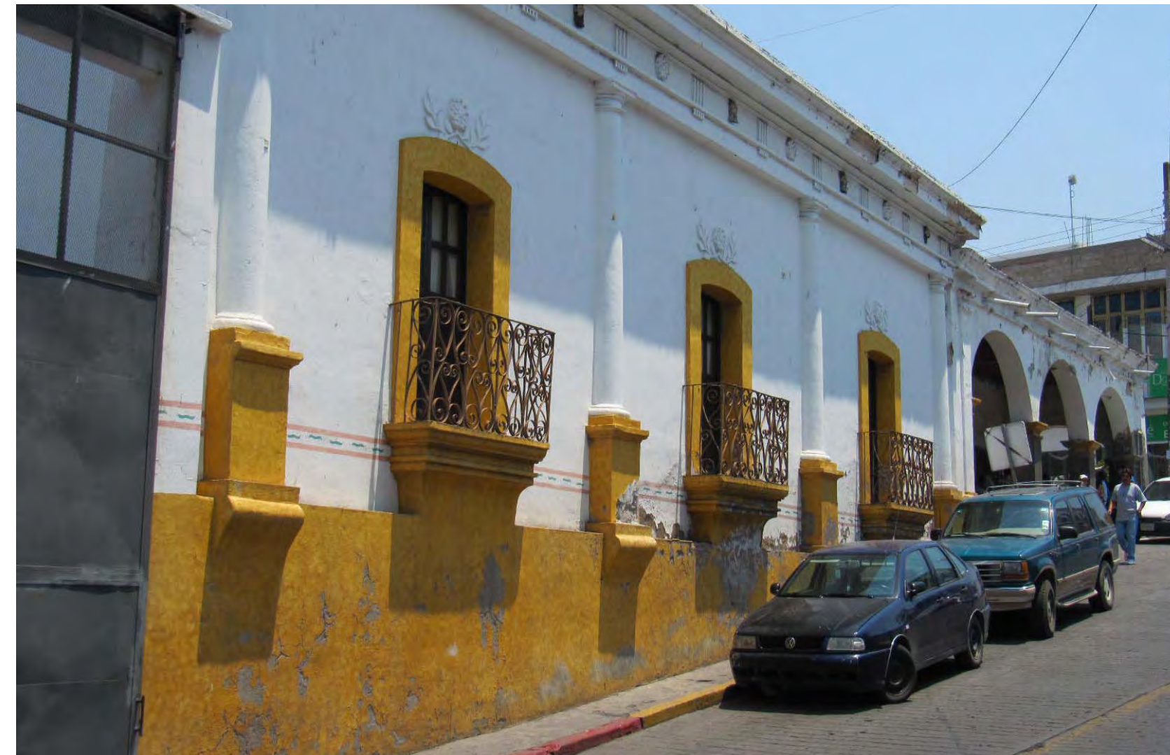
Imagen 22.- Arquitectura agroindustrial de finales del s.XIX en Morelos, copia en sus fachadas el uso de algunos recursos artísticos de elementos neoclásicos, (columnas, frisos y cornisas). Foto: fachada principal del molino de arroz El Soberano en Puentes de Ixtla, Morelos. Fotos: IPV Diciembre 2011.
