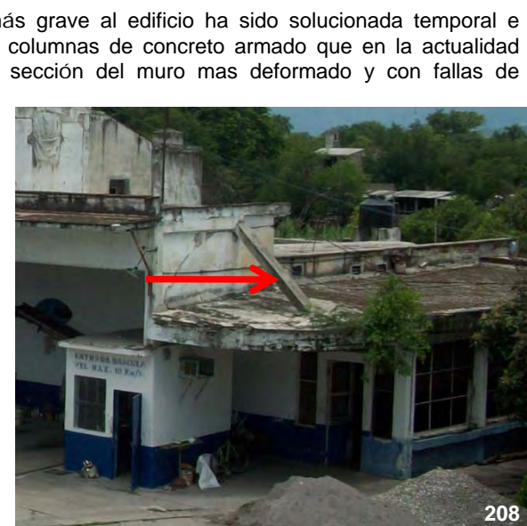
Imagen 207 y 208.- Deterioros por sobrecargas. El problema trato de ser remediado mediante la integración de una trabe de concreto armado (206), sin embargo, ésta situación produjo mayores afectaciones al muro que descarga el peso de la cubierta de concreto que se ubica sobre la báscula. Foto Molino San José, Diciembre 2011.
