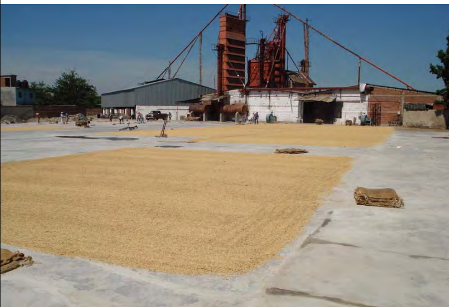
Imagen 109.- Patio de secado y secadora mecánica en Emiliano Zapata, Morelos. Foto IPV 2011
