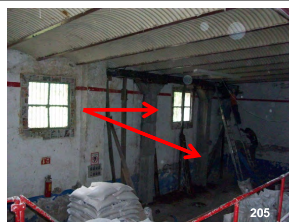
Imagen 205 y 206.- La afectación estructural más grave al edificio ha sido solucionada temporal e invasivamente mediante la integración de un par columnas de concreto armado que en la actualidad soportan la carga del sistema de azotea en la sección del muro mas deformado y con fallas de consideración. (muro suroeste).
