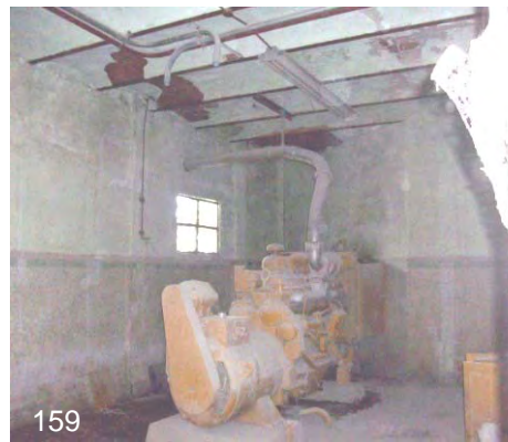
Imagen 158 y 159.- Planta de emergencia de mediados de siglo XX y tanques de diesel en el patio de cascarilla, vestigios de la antigua instalación eléctrica que sustituyó a la hidráulica, hoy en desuso.
