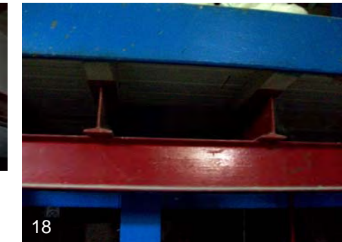
Imágenes 15-18.- El empleo de nuevos materiales en las construcciones de finales del siglo XIX como el acero en vigas y columnas, entresijos de bóvedas de ladrillo y lámina acanalada conocida como “Sistema Roebling”, sustituyó a los techos tradicionales de vigas de madera y terrados, (techos franciscanos). Fotos: Detalles constructivos del Molino San José, Jojutla, Morelos, Octubre 2011. IPV
