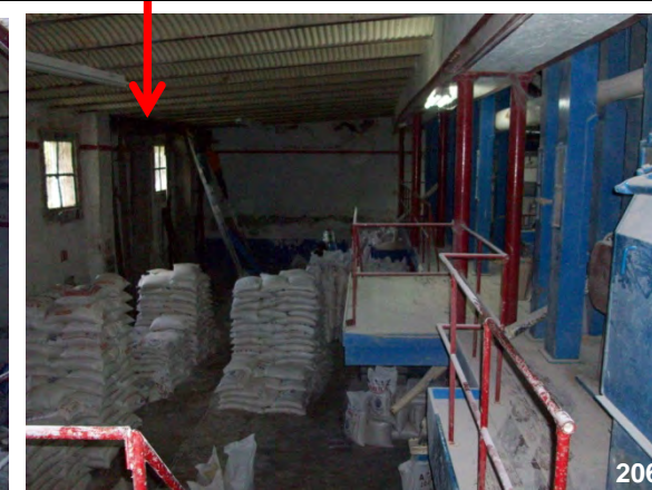
Imagen 205 y 206.- La afectación estructural más grave al edificio ha sido solucionada temporal e invasivamente mediante la integración de un par columnas de concreto armado que en la actualidad soportan la carga del sistema de azotea en la sección del muro mas deformado y con fallas de consideración. (muro suroeste).
