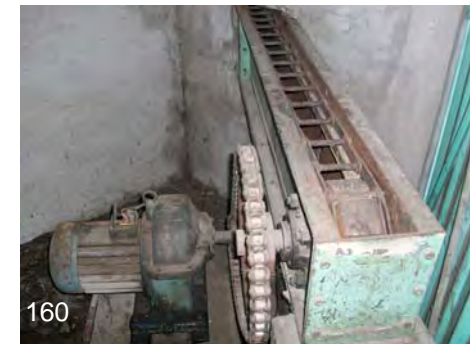
Imágenes 160 y 161.- Canalizaciones horizontales "Gusanos" para transportación del producto arroz entre edificios (en desuso) Fotos. IPV.
