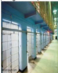
Gráfico 13. Instalación en las celdas.
