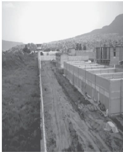
Gráfico 20. Edificio de control de acceso en Santa Marta Acatitla.
