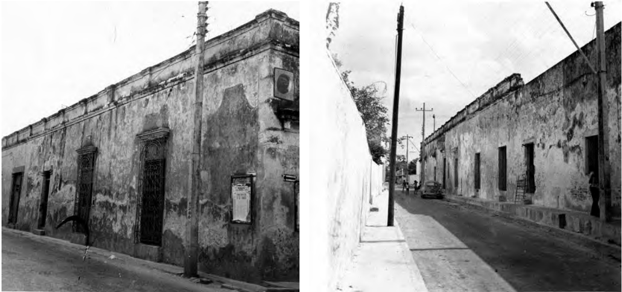
Imagen 70. Vestigios que sugieren la composición original de la fachada. Izquierda: paramento sur, Derecha: paramento oriente. Fuente: Fotografía de 1974 de la Fototeca Constantino Reyes-Valerio de la CMNH-CONACULTA-INAH-MEX.
