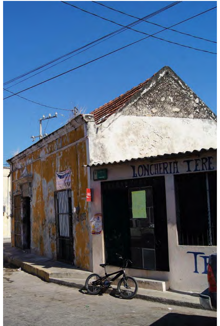
Imagen 86. Construcción del siglo XIX con techo de tejas de barro plana con estructura de madera en la Calle 16 por Gómez Farías en los límites del barrio de San Francisco.
