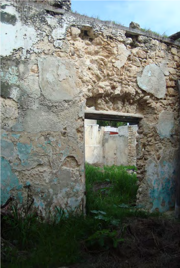
Imagen 82. Solución de cerramiento en capialzado en la vivienda 093. Se observan las piedras "tzales" acomodadas sobre un marco de madera. Fuente: Fotografía de abril de 2012 por el autor.
