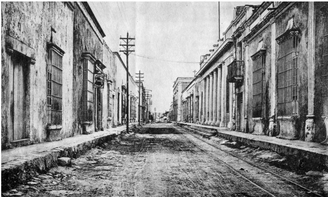
Imagen 50. Viviendas hispano yucatecas, dominaron la imagen urbana de la ciudad amurallada del siglo XVIII. Destaca la presencia de guardapolvos rematando las ventanas. Fuente: Teatro Francisco de la Paula Toro en 1910, en Ongay Pérez, op. cit., Estampa no. 32.
