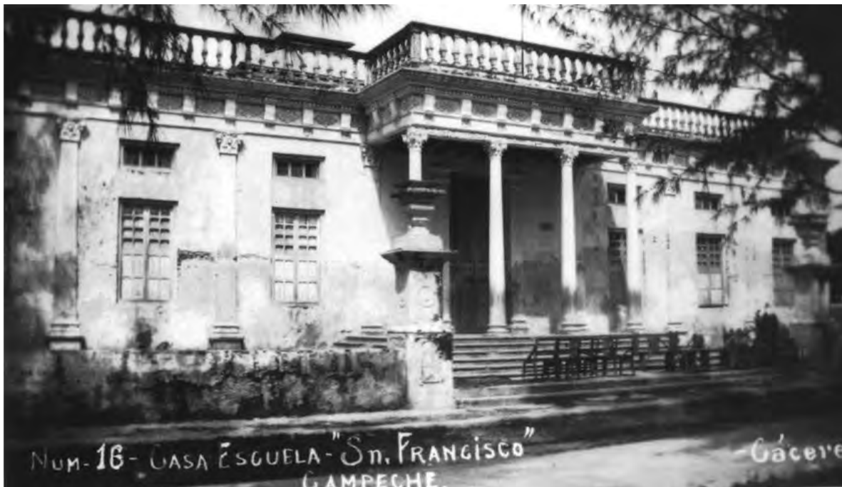
Imagen 21. Casa escuela San Francisco, ejemplo de género arquitectónico específico. Se encontraba en la Plaza de San Francisco fue derribada a inicios de los años 60s, durante los procesos modernizadores de la ciudad. Fuente: (Verduchi, 2010) p. 181.
