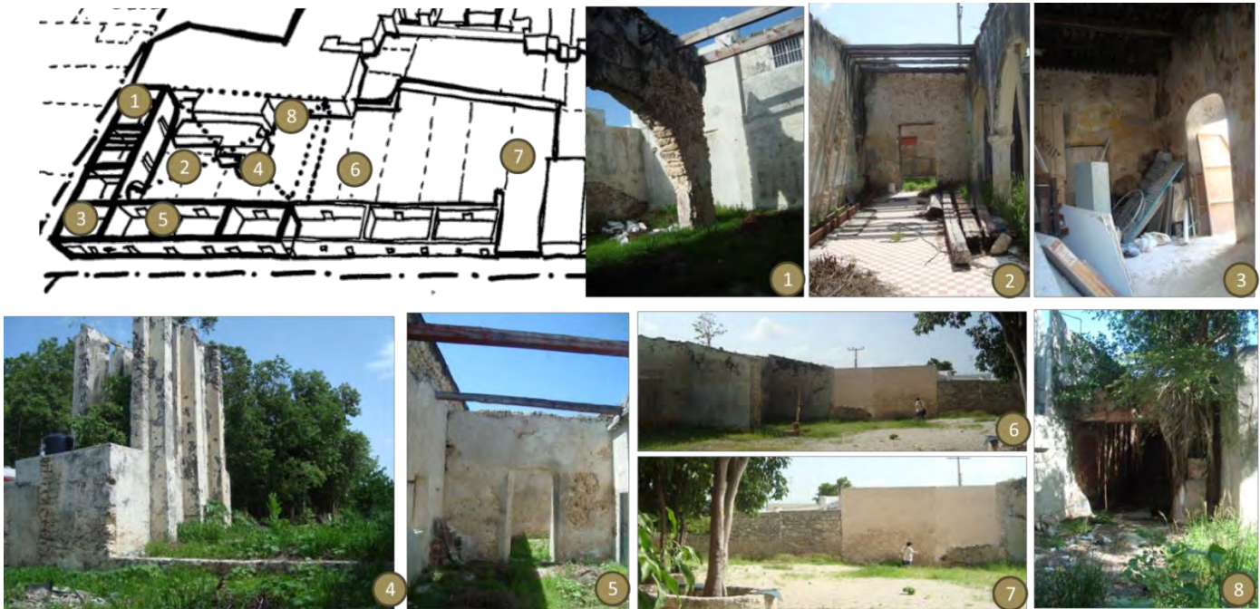
Imagen 97. Estado actual general del inmueble. Fuente: croquis y fotografías julio 2012 del autor.
