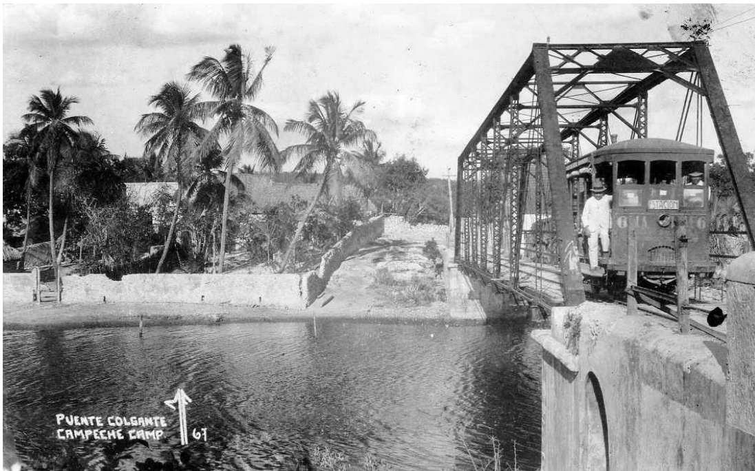
Imagen 33. Puente "Porfirio Díaz" para el paso de la línea de tranvías ca. 1910, la estructura fue traída directamente desde Nueva York,. Fuente: Grupo de Facebook "Recordar es vivir. Campeche, su historia". Fuente electrónica: https://www.facebook.com/photo.php?fbid=349523088479851&set=o.433946053314355&type=3
