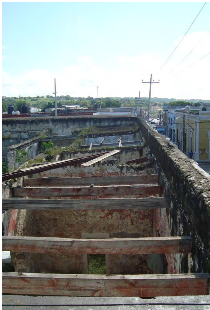
Imagen 85. Vista general del sistema de losas del inmueble 093 en el que se observan diversos tipos de vigas de madera. Hacia el fondo se observa la única losa que se conserva, una de vigas y viguetillas de madera. Fuente: Fotografía de septiembre de 2011, por el autor.
