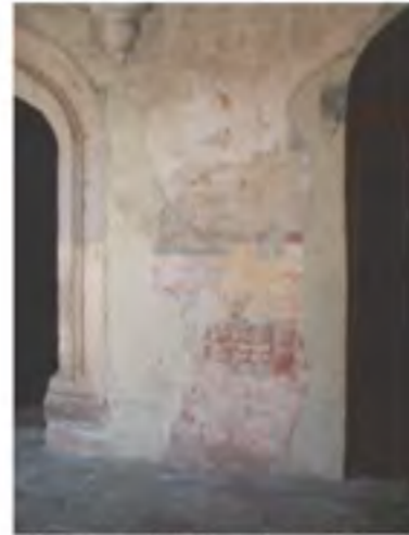
El muro presenta bufamientos en el aplanado, hay resanes de materiales distintos a los utilizados originalmente sobre la pintura mural. 02
