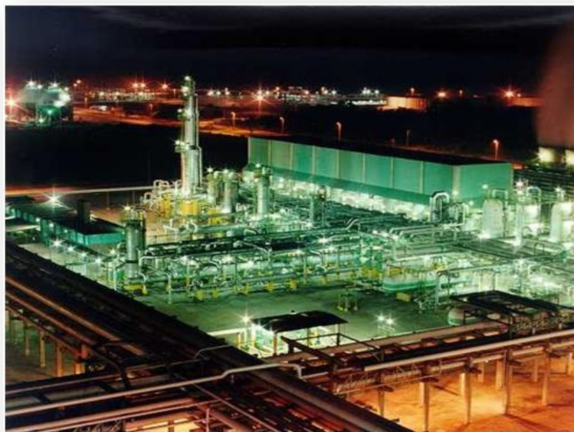
Figura 5.5 Instalación del complejo procesador de gas. Fuente: PGPB.
