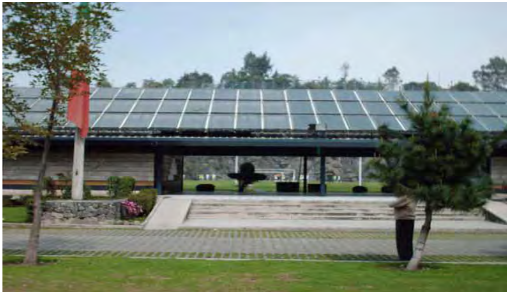
Figura 4.9 Integración arquitectónica de colectores solares a la estructura del inmueble Club Pumas - Cd. México
