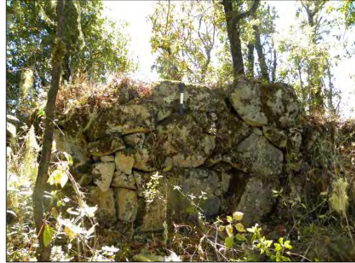
Foto V.123. Muro de Montículo II.
