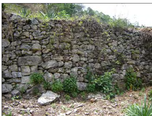
Foto V.13. Muros de contención.
