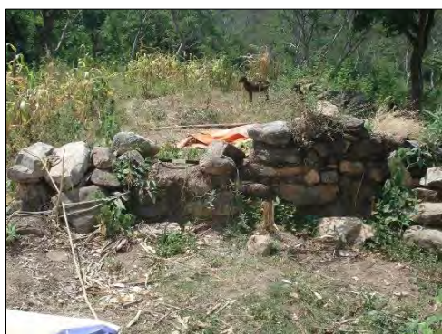
Foto V.45. Muro de estructura norte.
