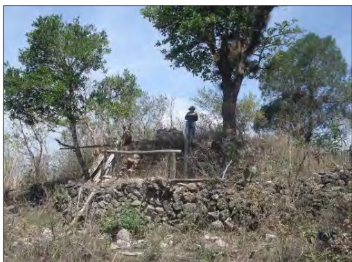
Foto V. 83. Fachada principal de Estructura I.
