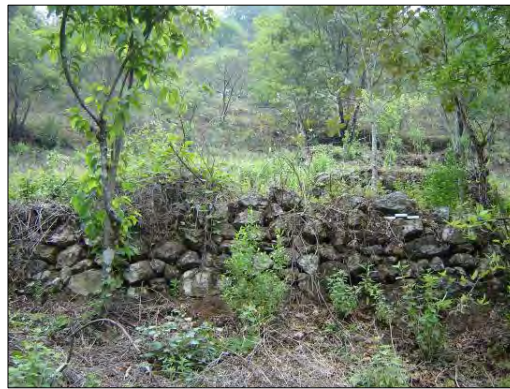
Foto V.14. Muros de contención.
