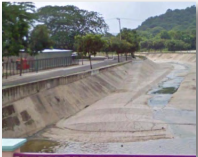
67.- CANAL DE AGUAS PLUVIALES.
