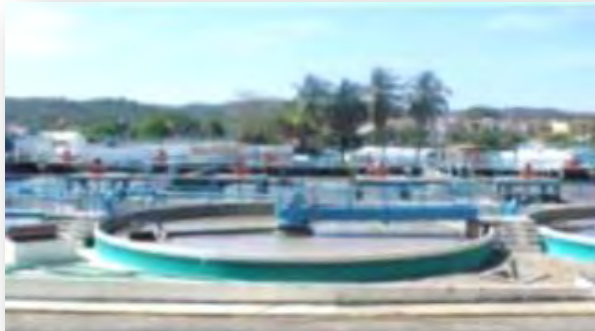
28.-PLANTA DE TRATAMIENTO DE AGUA.
