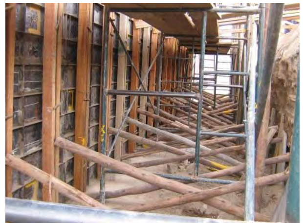
60.-MURO DE CONTENCIÓN.
