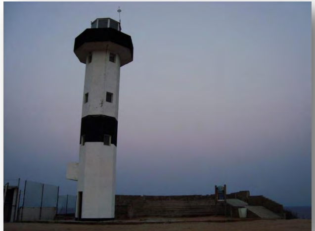
4.-VISTA ACTUAL DEL SITIO.
