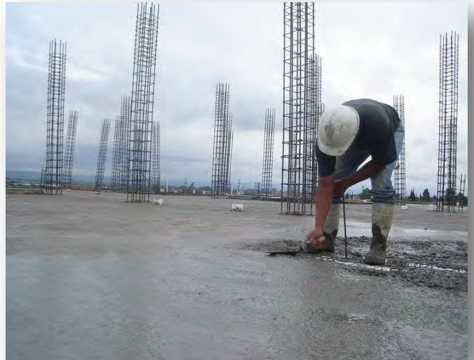
57.-LOSA DE CONCRETO ARMADO.
