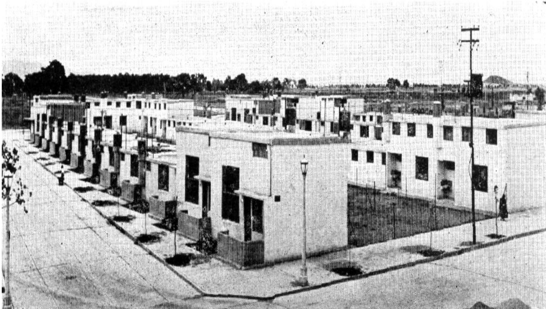
Conjuntos de viviendas para obreros que diseñó en México Juan Legarreta en los años 30.
