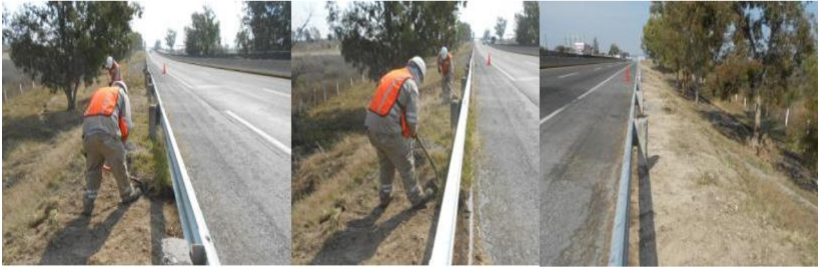
Imagen 5.8 Limpieza de defensas.
