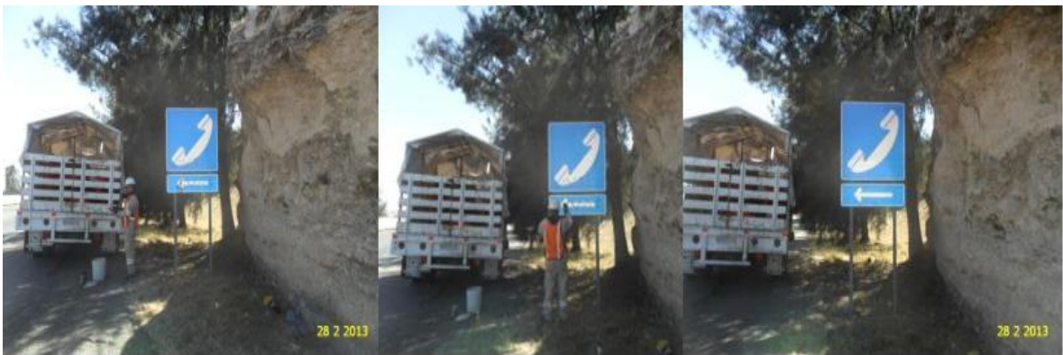
Imagen 5.7 Limpieza de señales verticales.
