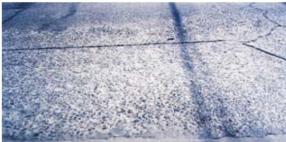
Imagen 4.30 Desintegración.
