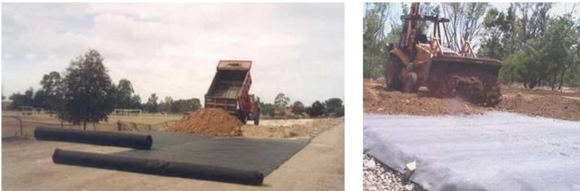
Imagen 6.1 Uso de Geotextil para estabilización y separación de las capas de un pavimento.
