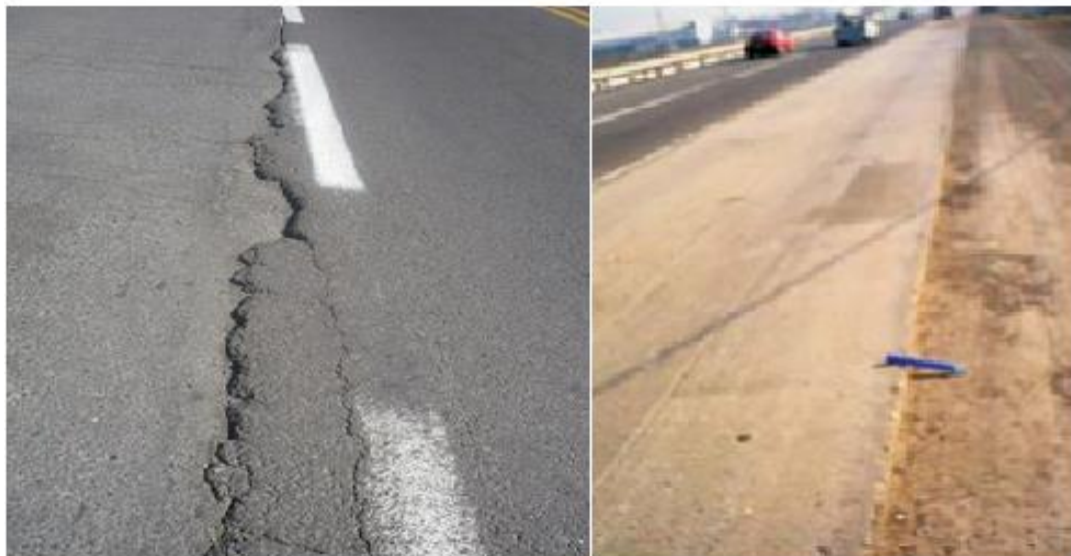
Imagen 4.38 Descenso de la berma.
