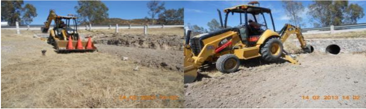
Imagen 5.4 Desazolve de canales de entrada y salida en obras de drenaje.
