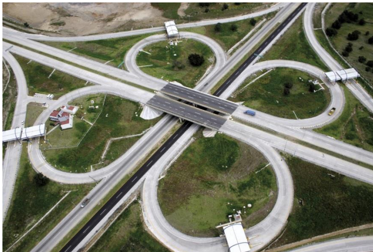
Imagen 1.2 Carretera de concreto (Arco Norte, Cd de México).
