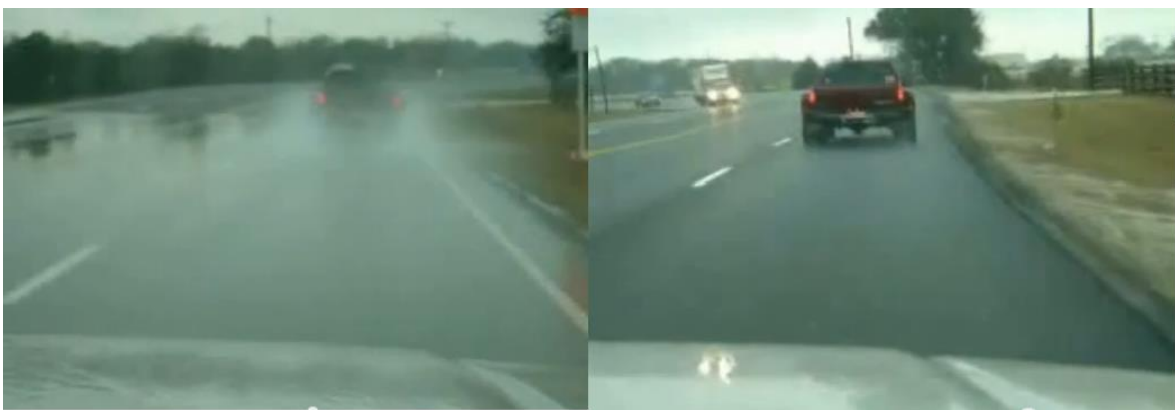
Imagen 5.9 Antes y después del tratamiento "Open Grade".
