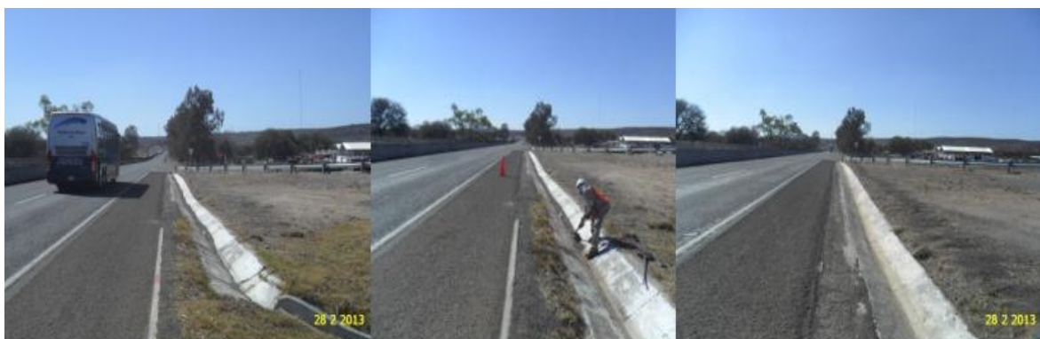
Imagen 5.3 Limpieza de cunetas.
