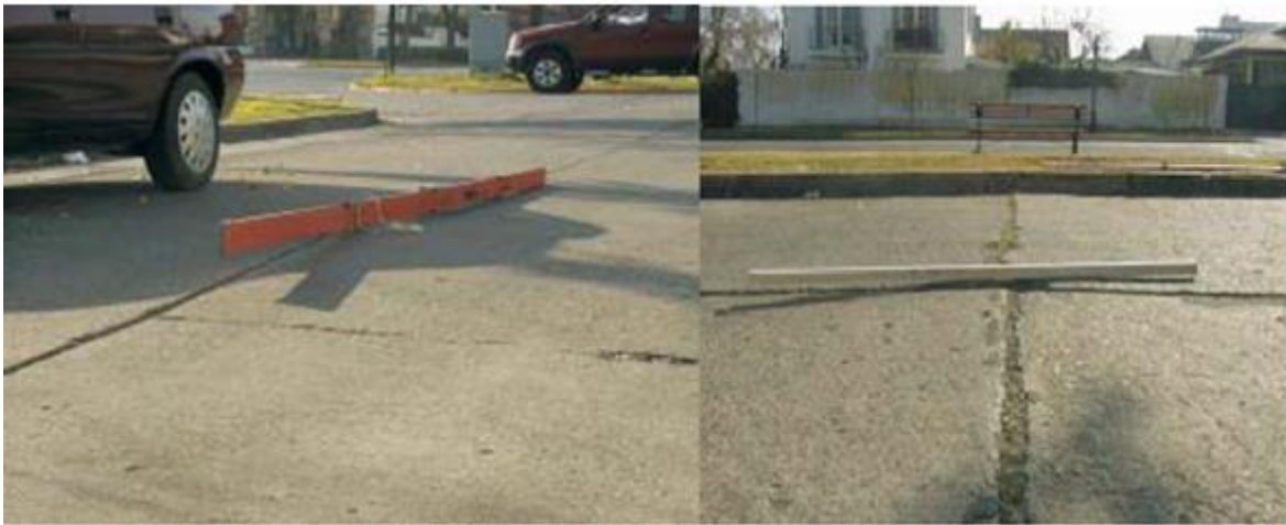
Imagen 4.35 Levantamiento.
