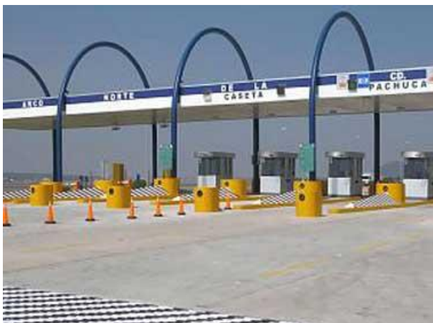
Imagen 6.13 Casetas de la carretera “Arco Norte”
