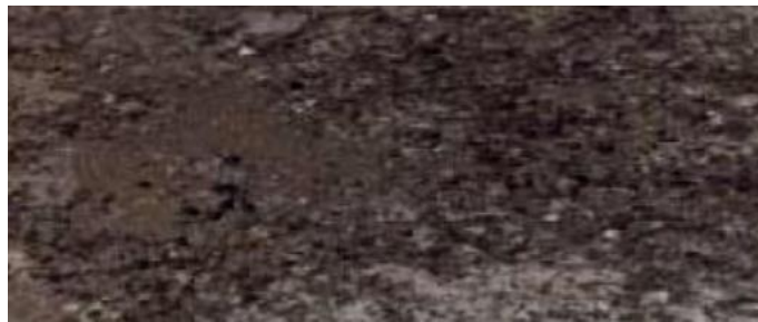
Imagen 4.32 Descascaramiento y fisuras capilares.
