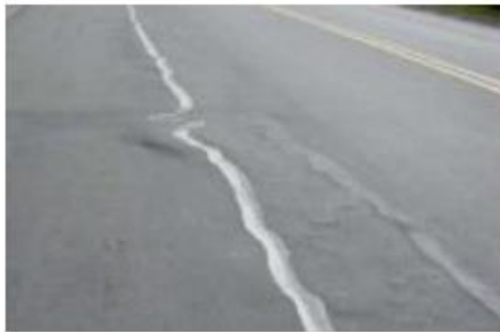
Imagen 4.10 Ondulaciones transversales.
