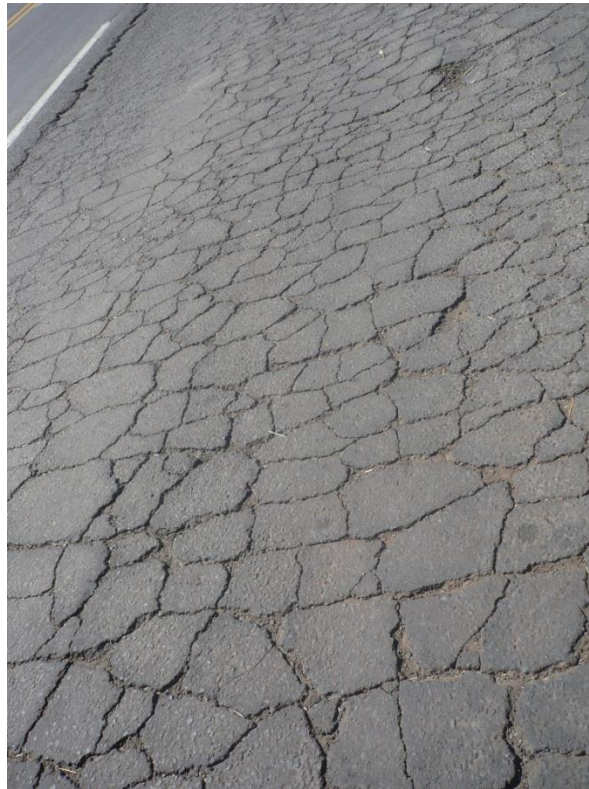
Imagen 4.3 Desintegración.
