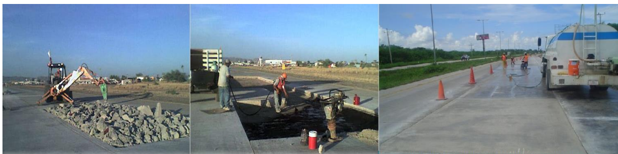
Imagen 5.11 Reposición de losas de concreto hidráulico.
