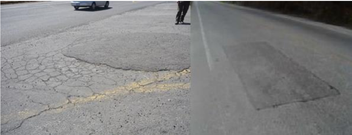
Imagen 4.21 Reparación de la estructura del pavimento.
