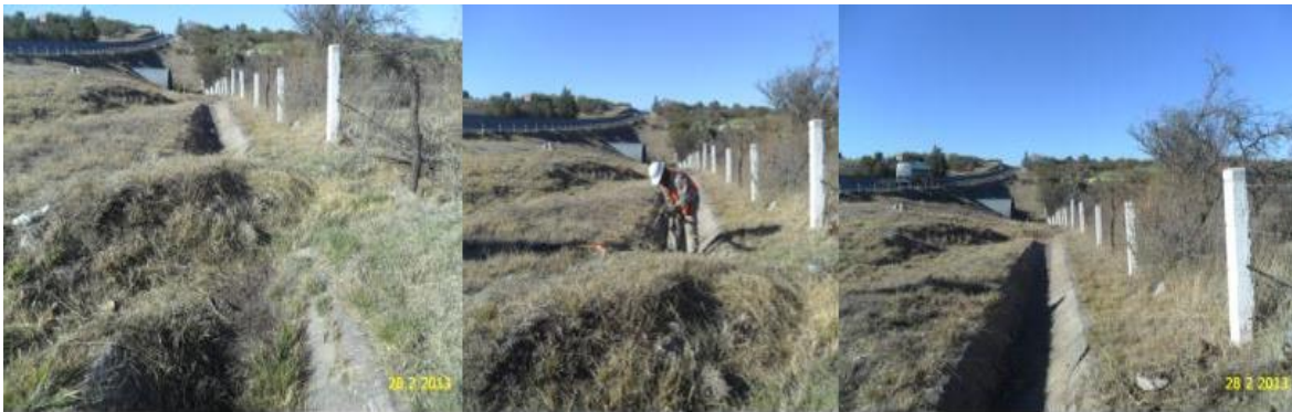
Imagen 5.5 Desazolve de contracunetas.
