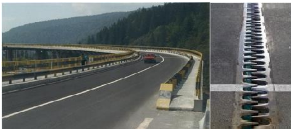
Imagen 5.6 Limpieza en juntas de dilatación, parapetos, banquetas y camellones.
