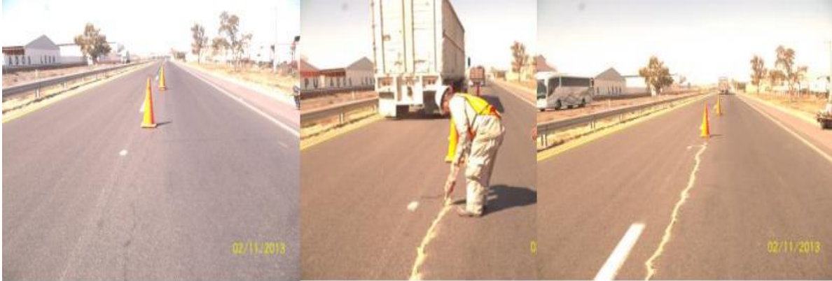
Imagen 5.1 Sellado de grietas.
