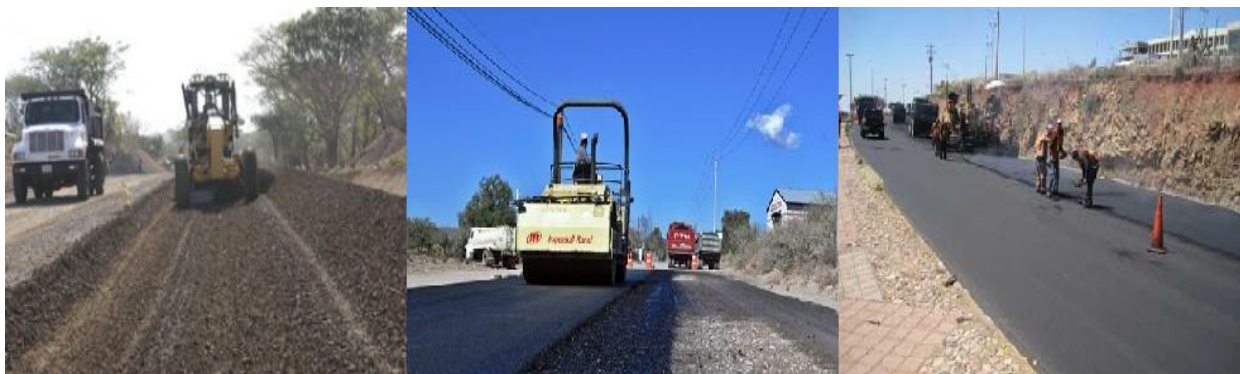
Imagen 5.12 Reconstrucción o reparación mayor.
