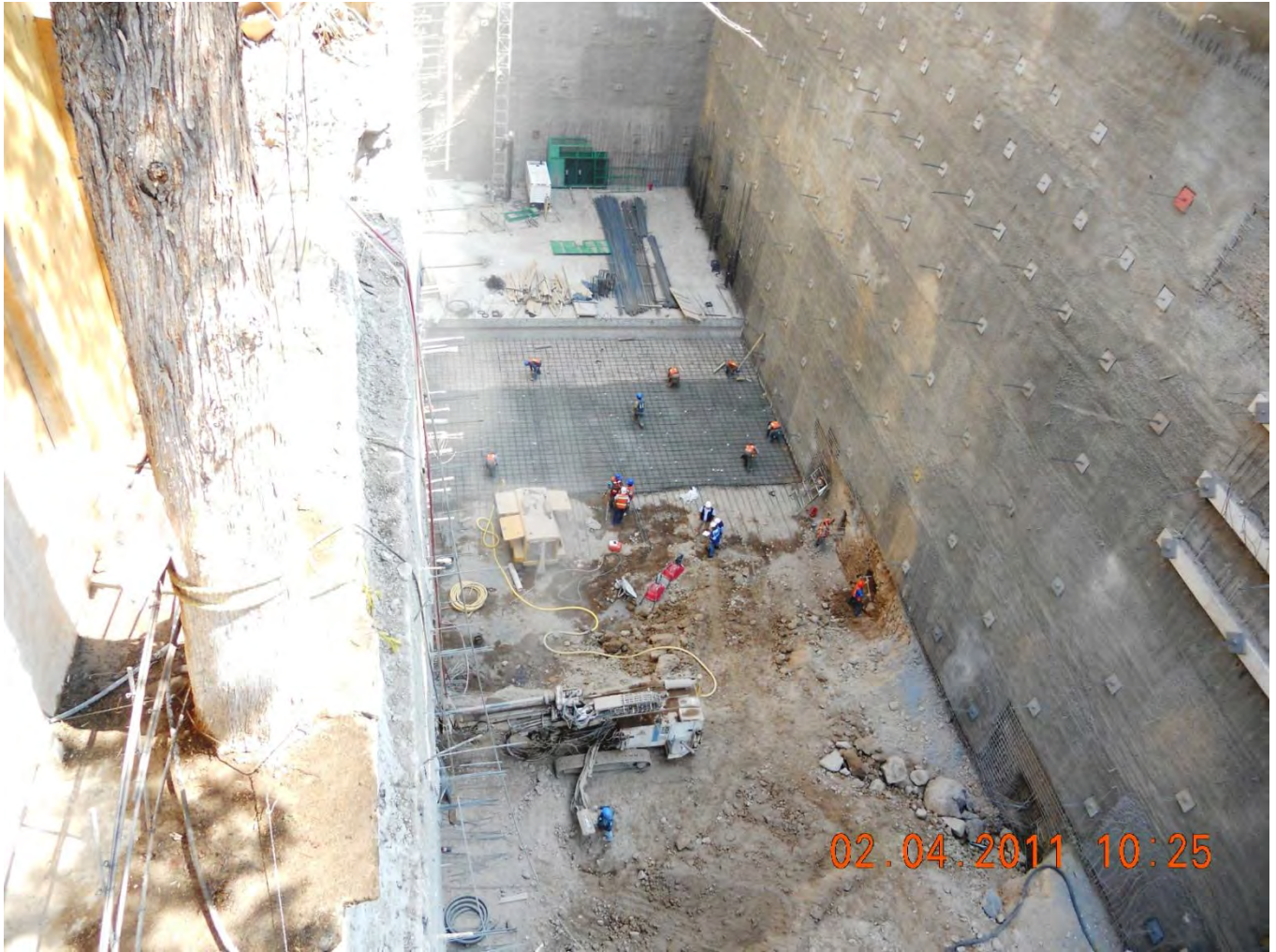
Losa de Cimentación - 2 de Abril de 2011
