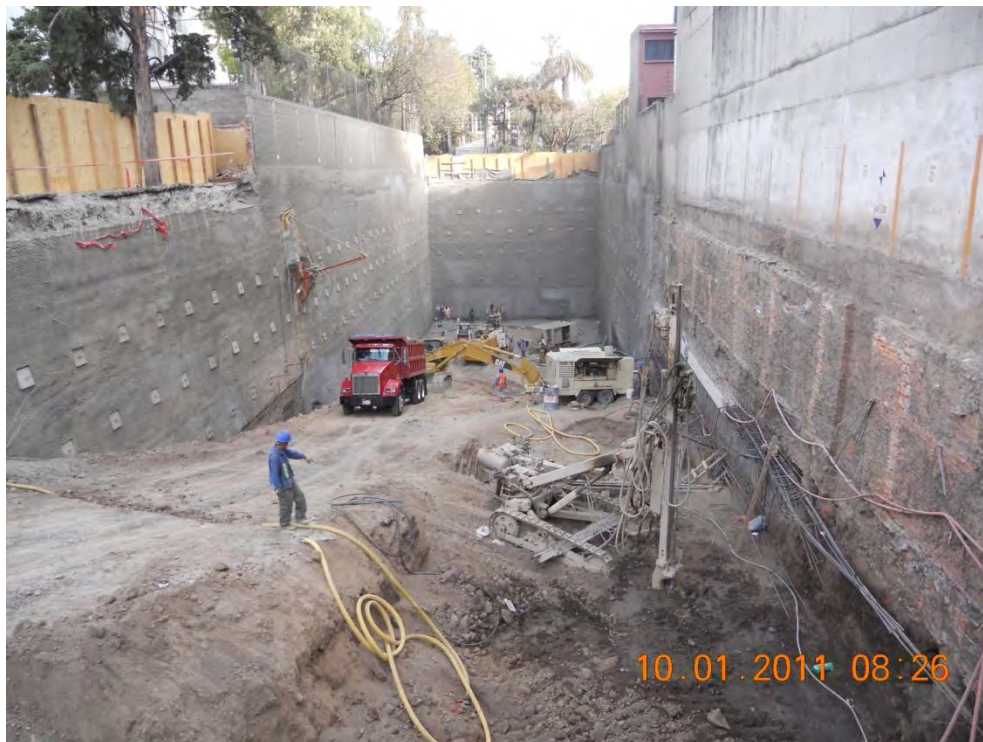
Trabajos de Concreto Lanzado y Excavaciones – 10 de Enero de 2011
