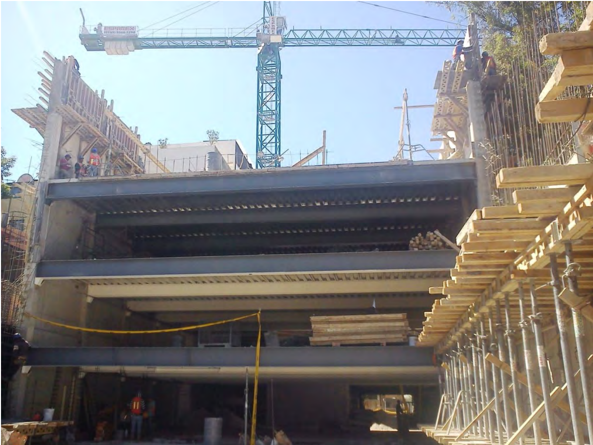
Losa de entrepiso en estructura metálica, lámina y concreto
