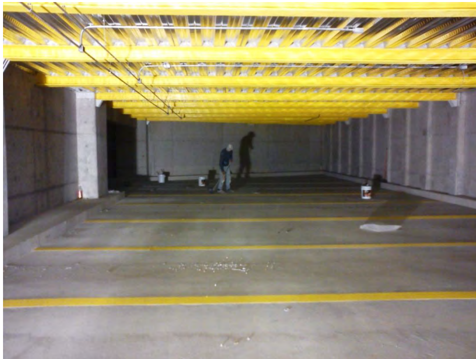
Cancelería en vidrios, pintura de sótanos, en piso y estructura metálica
