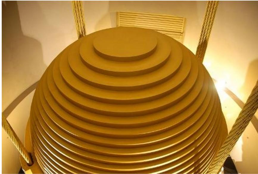
Imagen 3.4 Tanque como disipador de energía.
