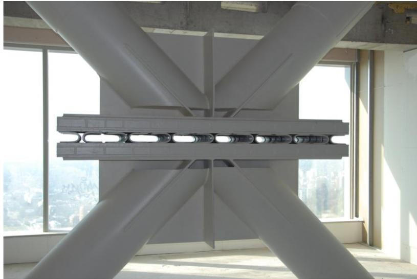
Imagen 3.5 Disipador metálico.
