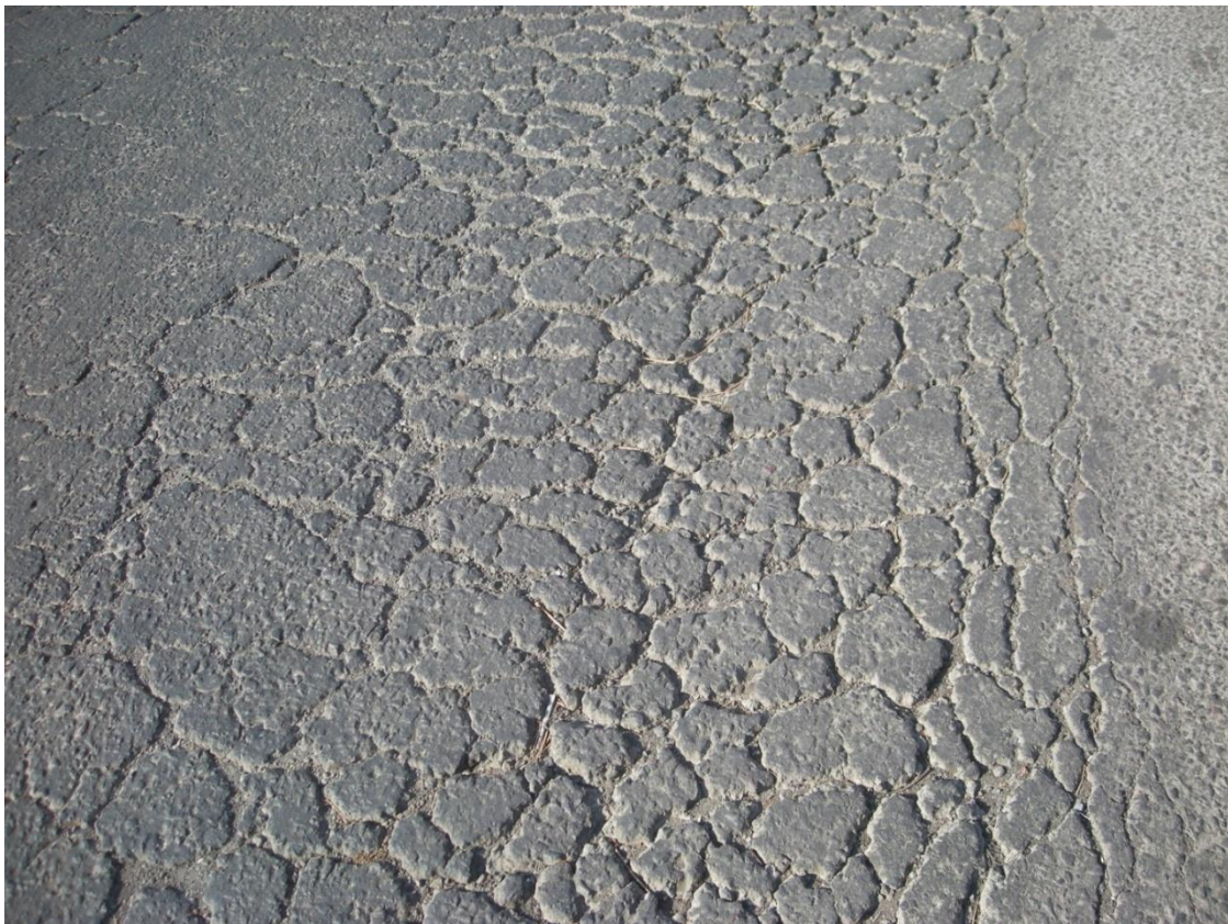
Fotografía 3.3 Estado actual del camino (Fuente: Propia)
