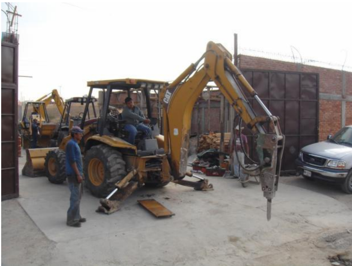
Fotografía 5.1 Retroexcavadora con rotomartillo. (Fuente: Propia)
