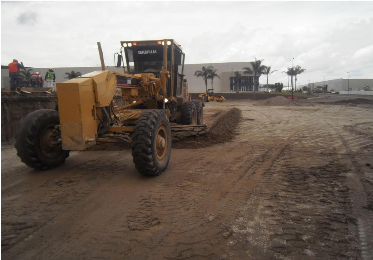
Fotografía 5.4 Motoconformadora. (Fuente: Propia)
