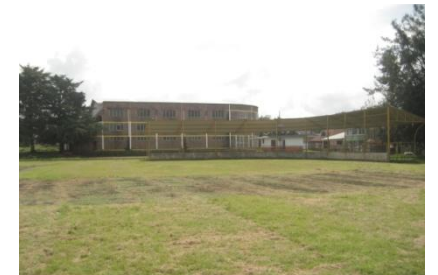
Terreno, área de espectadores, y auditorio municipal.
