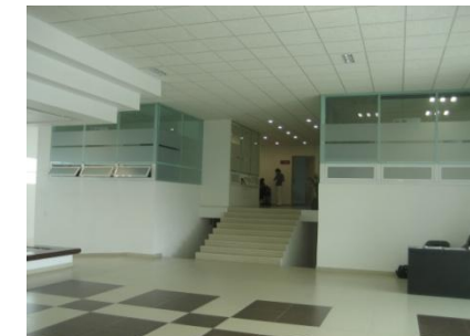
Se tienen escalones muy peraltados del vestíbulo al área de oficinas
