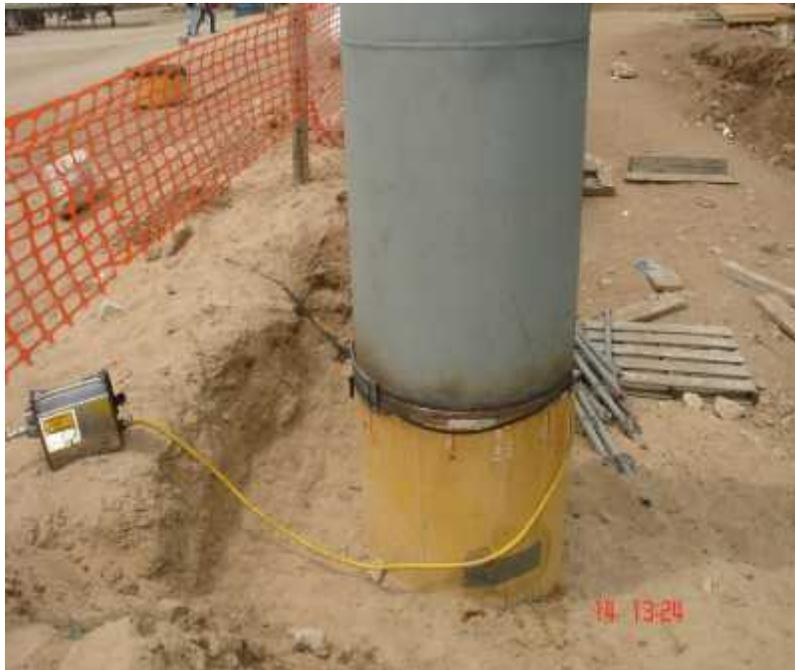
**Imagen 14. Soldadura a inspeccionar por E.N.D radiográfico**
