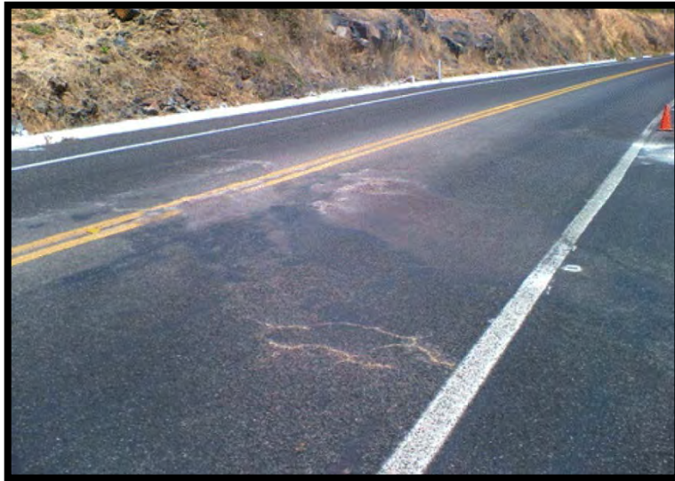
Foto del daño hundimiento y filtración en carpeta asfáltica.
