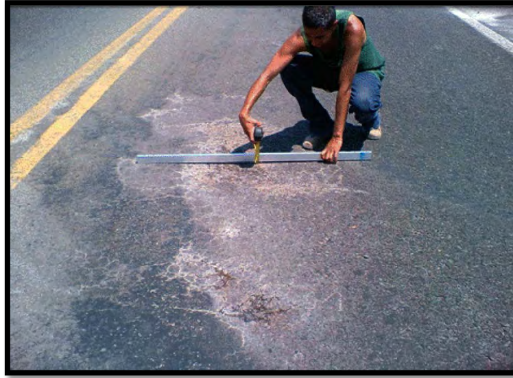
Foto del daño hundimiento y filtración en carpeta asfáltica.
