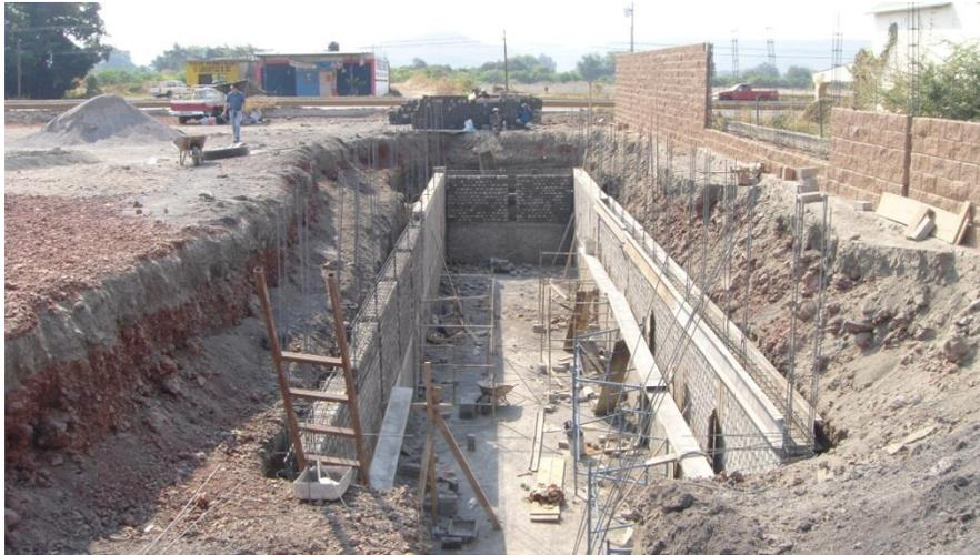
Foto 4.9.- Excavación y construcción de muros donde serán ubicados los tanques.
