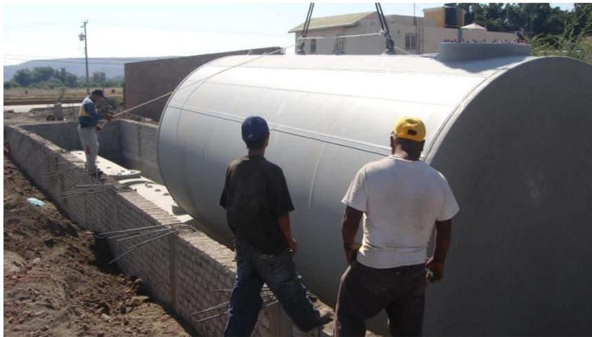
Foto 4.10.- Colocación de tanques de Magna, Premium y Diesel.
