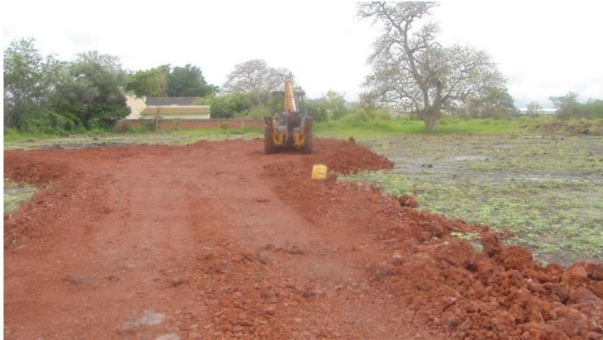
Foto 4.7.- Despliegue de la arena para la iniciación de la plataforma.
