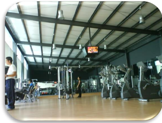
31 Estructura metálica cubierta con lámina multitecho.
