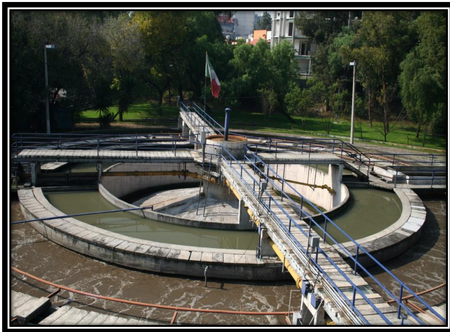
Figura 3.30 Vista general de reactor biológico circular. Se encuentra en el borde extremo del círculo, en el interior se aprecia el sedimentador primario.
