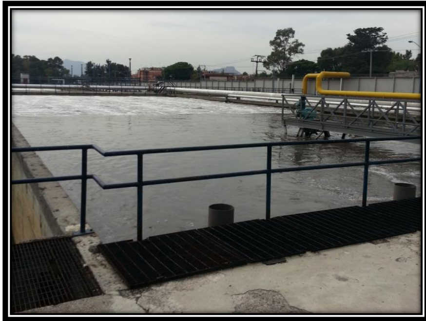
Figura 3.5 Imagen de reactor biológico ampliado hacia zona de sedimentación primaria con bioselector anóxico y posterior aireación.
