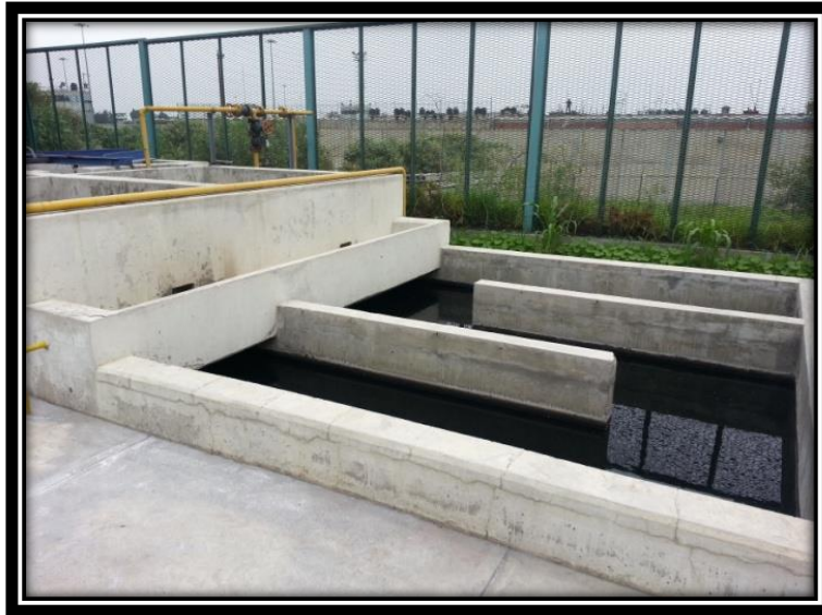
Figura 3.12 Desinfección con hipoclorito por goteo y laberinto para aumentar el tiempo de contacto para mejores resultados.
