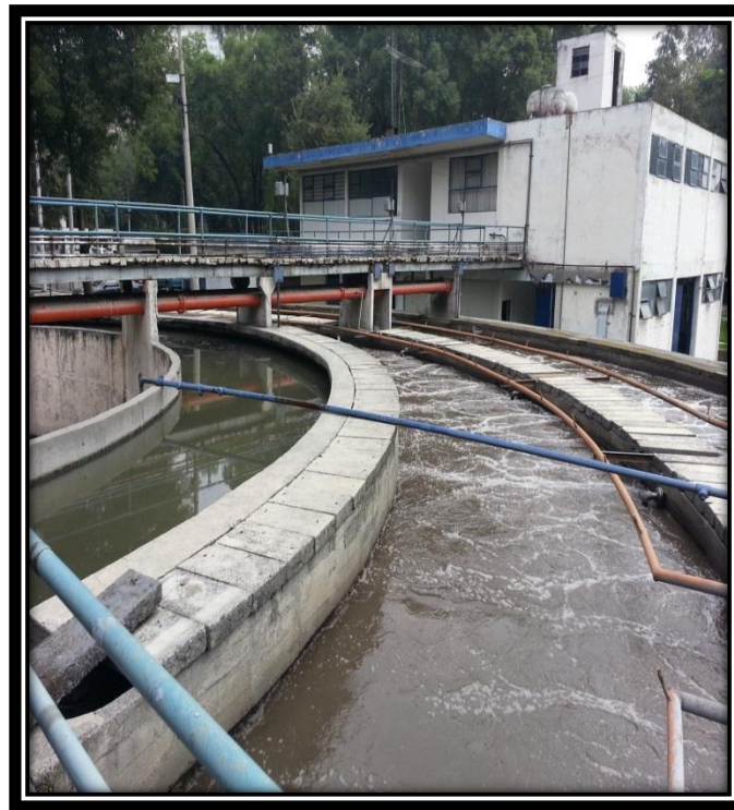
Figura 3.28 Tanque circular. En la parte interior del tanque se encuentra el sedimentador primario y en la exterior el reactor biológico. Forma parte del tren de tratamiento II.
