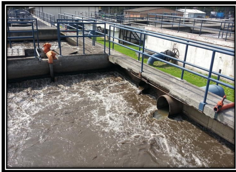
Figura 3.20 El agua llega de los sedimentadores primarios por la tubería de mayor diámetro, mientras que la recirculación de los lodos se observa en la tubería adyacente de menor diámetro.
