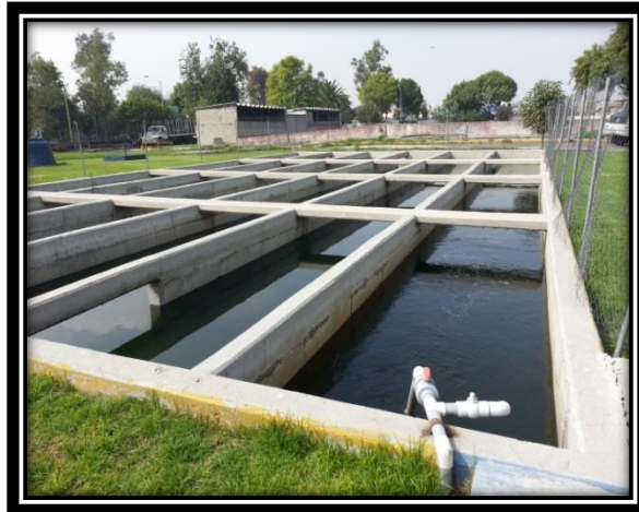
Figura 3.22 Tanque tipo laberinto e instalación para inyección de gas cloro al agua residual.
