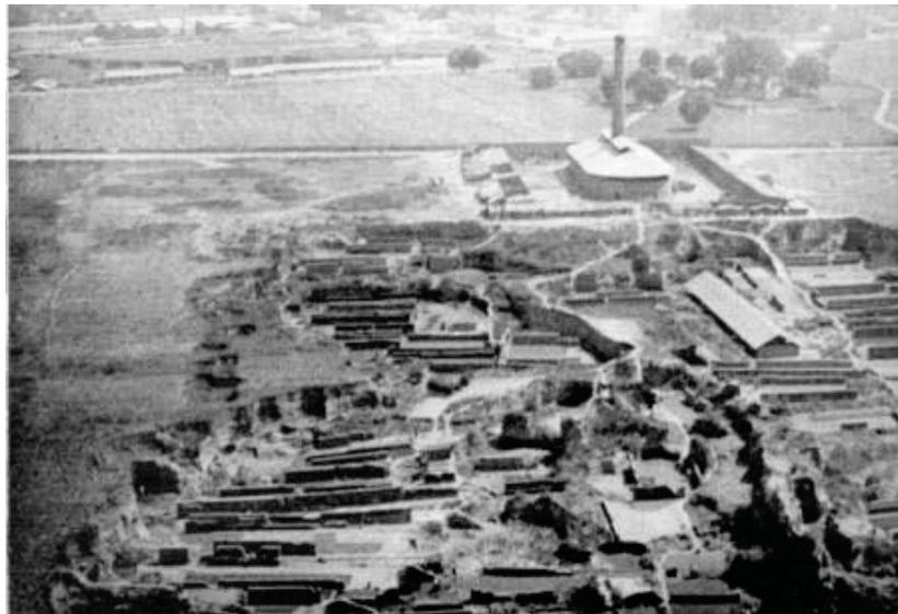
**Imagen 69: FABRICA DE LADRILLO LA GUADALUPANA EN MIXCOAC, 1920.** En esta imagen podemos apreciar la amplitud de la fábrica, así como los grandes huecos hechos para poder extraer las excelentes arcillas que proporcionaban las tierras de Mixcoac para fabricar los ladrillos. Muchos de estos ladrillos fueron comercializados con la ciudad de México y otros utilizados en las construcciones nuevas en Mixcoac. (Pensado, video, 1996).
