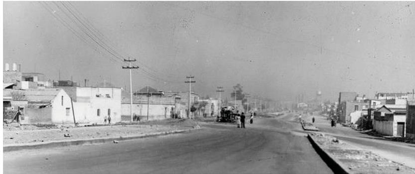
**Imagen 34: PAVIMENTACIÓN CALLE FÉLIX CUEVAS, EJE 7 SUR, MARZO 1941.** En la imagen se observa la Avenida Félix Cuevas en la conclusión de la obra de pavimentación y ensanche del tramo que llega hasta la Avenida Revolución. En esta obra fueron demolidos varios inmuebles que impedían el ensanche de la vía. (Museo Archivo de la Fotografía. Guatemala 32, Centro Histórico de la Ciudad de México).
