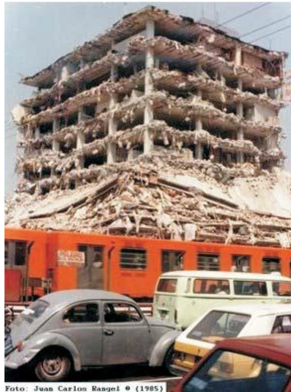
Figura 2.16 Afectaciones en un edificio de la ciudad de México ubicado sobre calzada de Tlalpan por el sismo de 1985, (SEGOB, 2010)
