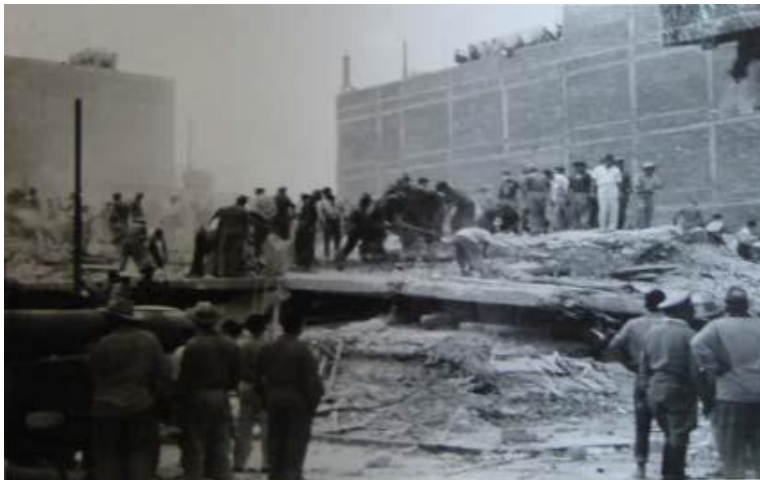
Figura 2.9 Edificio colapsado en esquina de las calles de Frontera y Álvaro Obregón. (Reinoso y Orozco, 2007).
