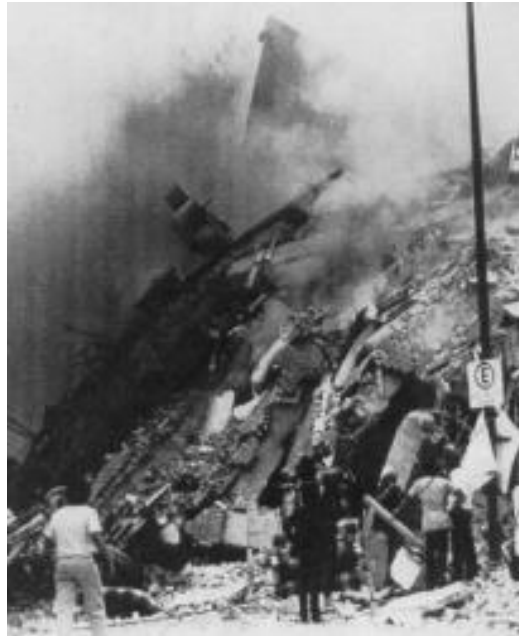
Figura 2.12 Edificio derrumbado y humeante en la calle San Juan de Letrán en el Distrito Federal (Bitrán, 2001)
