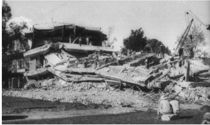
Figura 2.8 Colapso del ala sur del edificio del IPN a causa del sismo de 1957 en la ciudad de México (Reinoso y Orozco, 2007).
