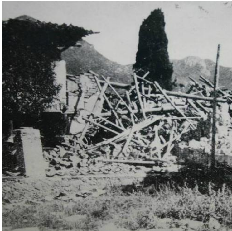
Figura 2.3. Ruinas de una casa después del sismo (Serrano, 2001)
