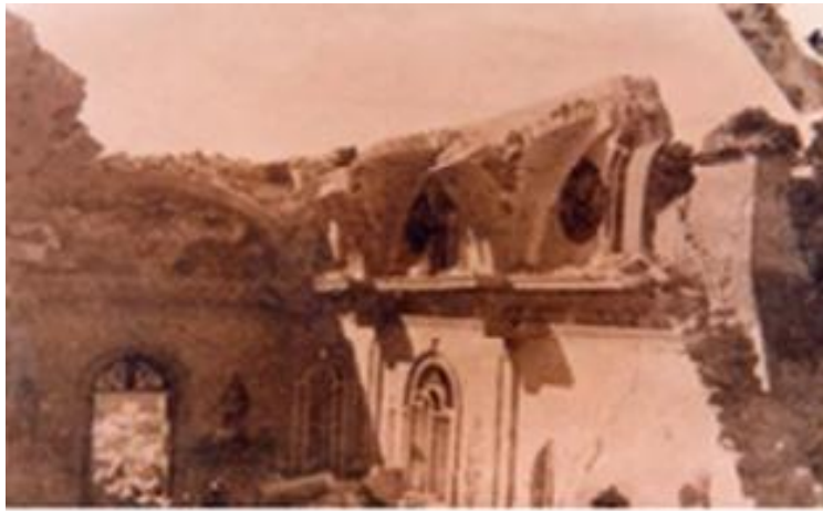
Figura 2.2. Iglesia de Acambay destruida por el sismo (Serrano, 2001).
