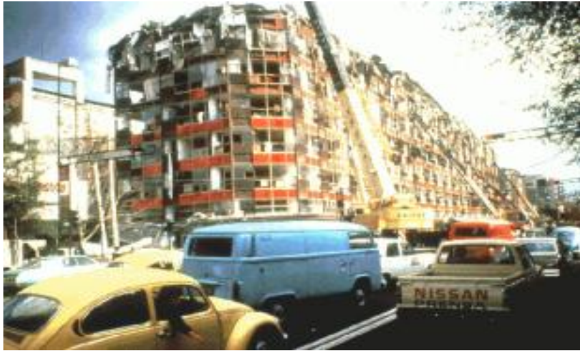
Figura 2. 14 Colapso del edificio de la Secretaría de Comercio en el Distrito Federal (Bitrán, 2001)
