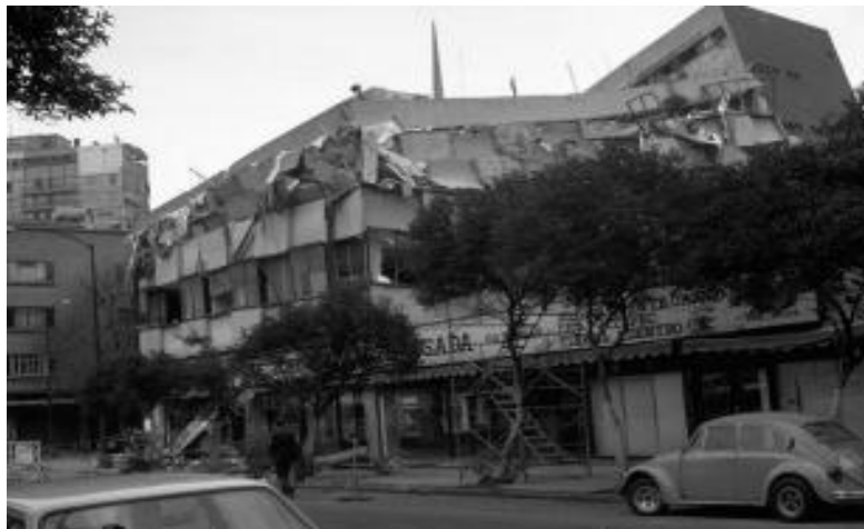
Figura 2.13 Daños en edificio de departamentos ubicado en la Zona Rosa del Distrito Federal (Bitrán, 2001)
