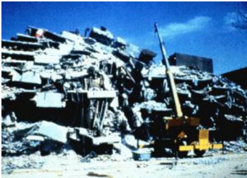
Figura 2.15 Colapso total del Hospital Juárez, (Bitrán, 2001)
