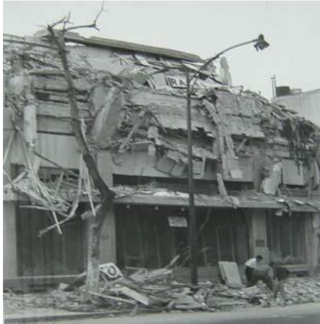
Figura 2.10 Edificio en Insurgentes # 377, sólo la planta baja quedó en pie (Reinoso y Orozco, 2007).
