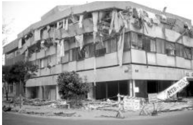
Figura 2.17 Edificio colapsado parcialmente (fascículo cenapred)
