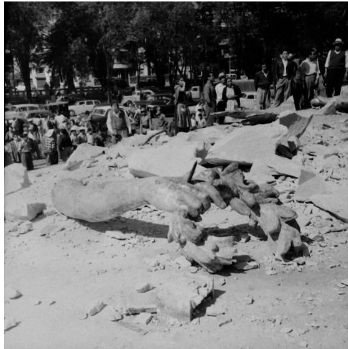
Figura 2.6 Fracturamiento del Ángel (Montero, 2012)
