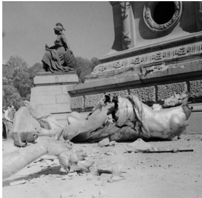
Figura 2.7 Colapso del Ángel de la Independencia vista desde otro ángulo (Montero, 2012)
