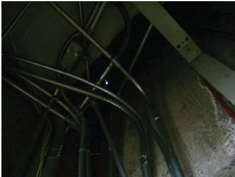
Segundo Nivel (oquedad)
