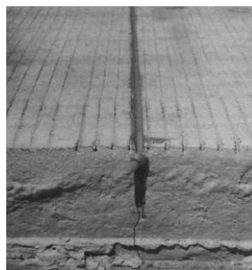
Fig. 3.3. Sellado de juntas.
